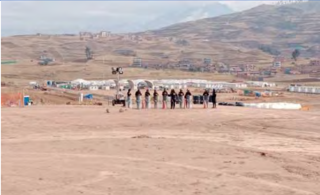
Resguardo policial producto de las protestas por parte de los comuneros, en la zona de construcción del aeropuerto internacional de Chinchero.
