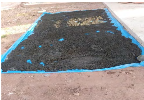
Secado de agregado fino Escoria de hornos ELÉCTRICOS.
