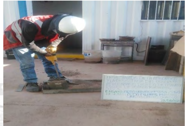
Compactado para Peso seco compactado de Agregado fino de Supermix.
