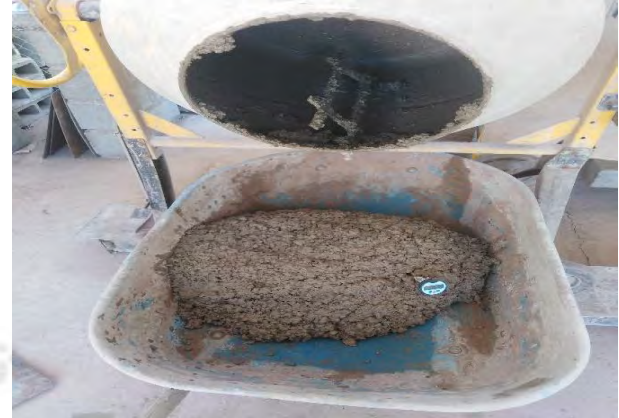
Control de temperatura del concreto (CC)
