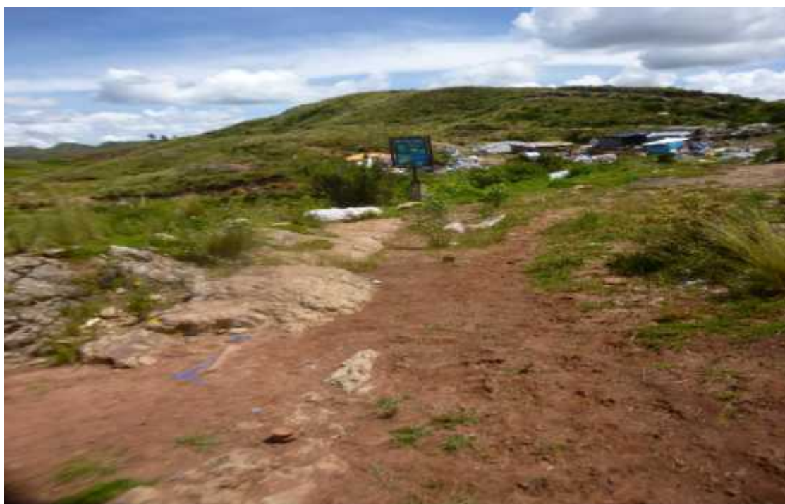
BOTADERO DE RESIDUOS SÓLIDOS DE JAQUIRA ENCIMA DEL TRAYECTO DEL QHAPAQ ÑAN AL CONTISUYO.- La red vial andina se encuentra destruida y distorsionada con presencia de residuos solidos de basura. FUENTE: Propia Tesista
