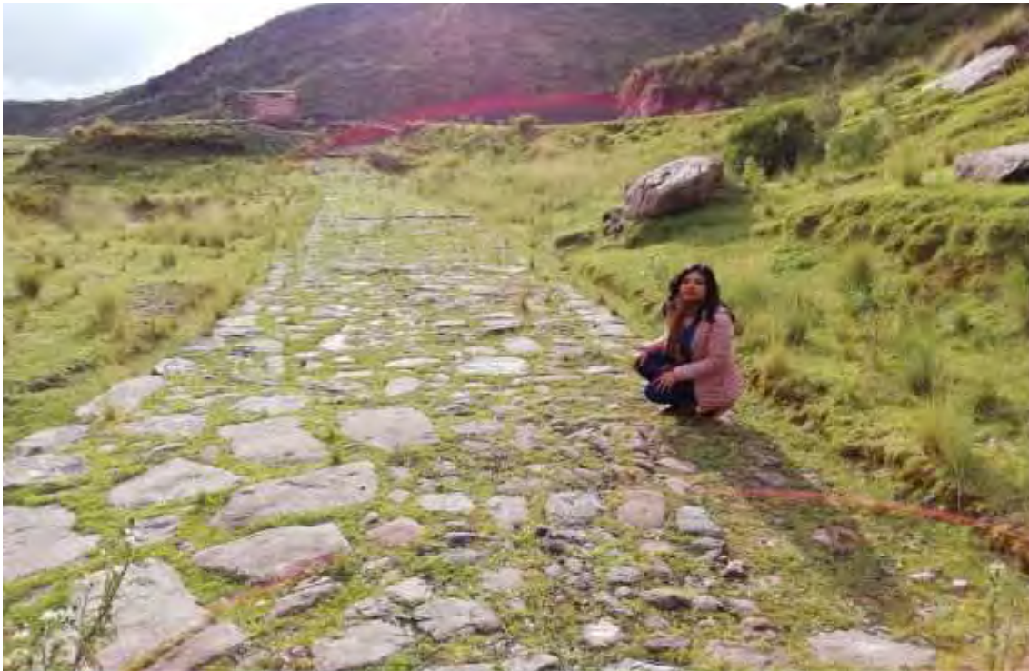
DESCENSO POR EL SECTOR DE CH'USPI Q'ASA PAMPA.- Proyeccion del camino real del Contisuyo con la presencia de drenes y canales de agua. FUENTE: Propia Tesista
