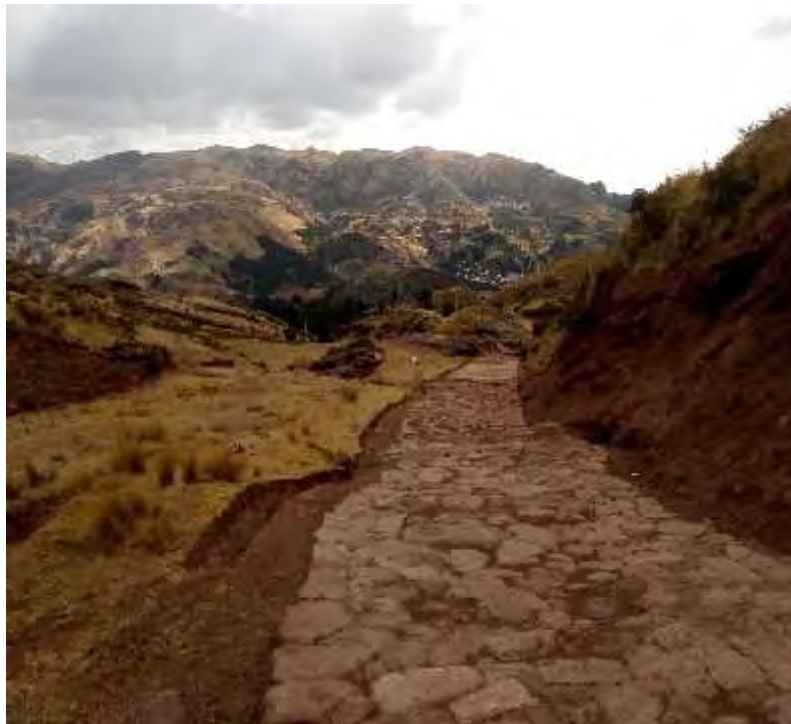
ABRA DE LLAULLI Q´ASA.- El camino real se halla en buenas condiciones con la presencia de canales y drenes. FUENTE: Propia Tesista
