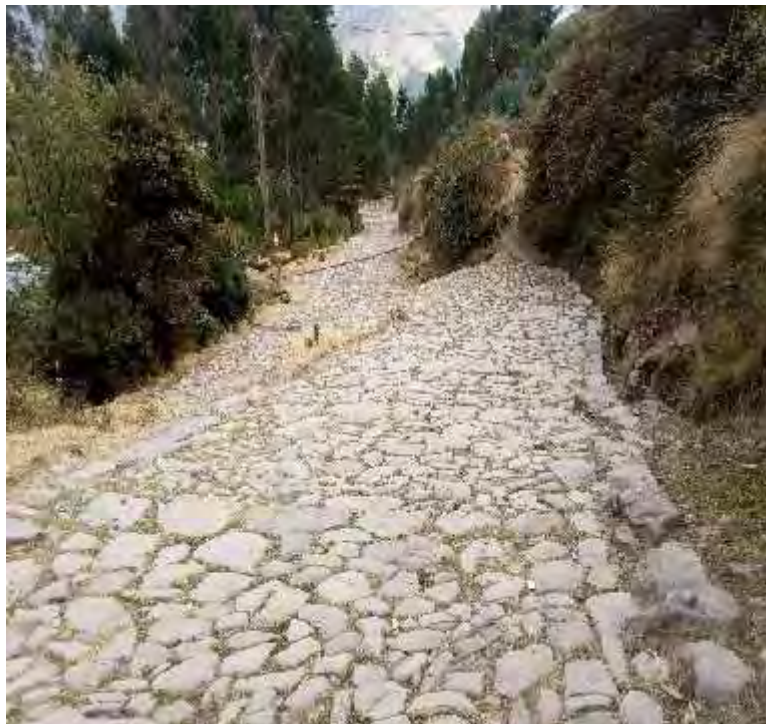
SECTOR DE LLAQUEO HUAYLLA.- Sector donde se muestra la presencia de escalinatas de piedra. FUENTE: Propia Tesista.
