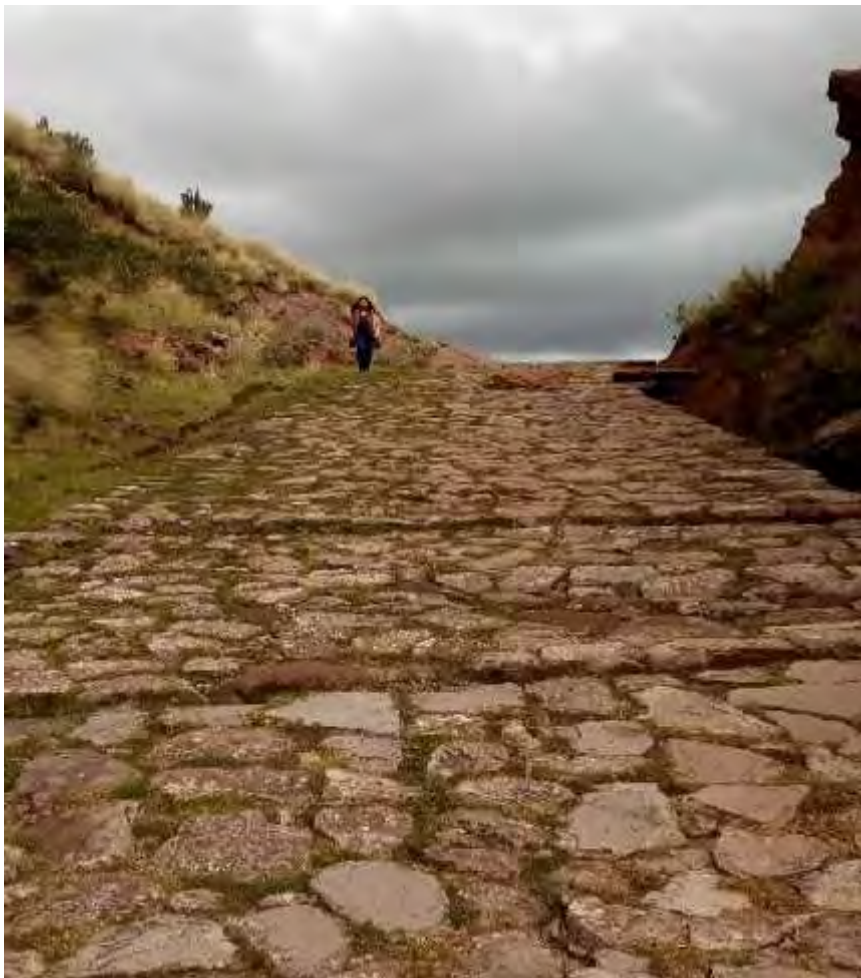
ABRA DE LLAULLI Q´ASA.- El camino real se halla en buenas condiciones con la presencia de canales y drenes. FUENTE: Propia Tesista
