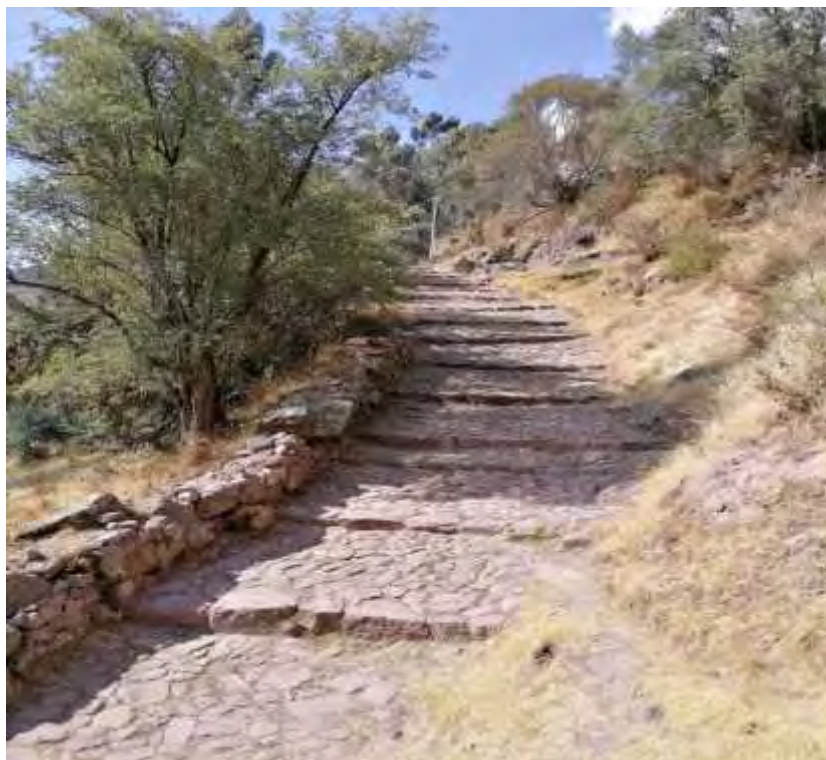
SECTOR DE LLAQUEO HUAYLLA.- Proyección del camino real del Contisuyo hacia el Tambo de Ccorca. FUENTE: Propia Tesista
