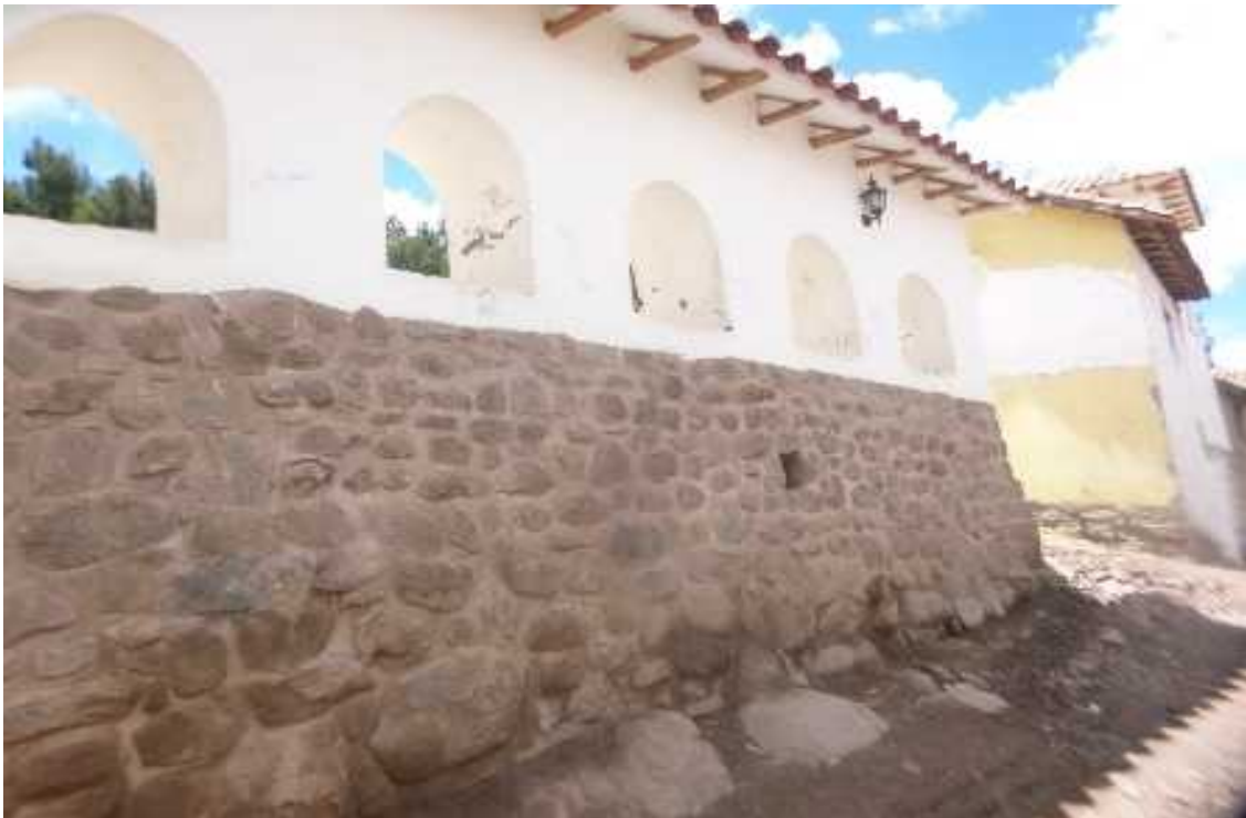
FACHADA DEL MURO DEL TEMPLO RESTAURADO DE SANTIAGO APOSTOL DE CCORCA CON CIMIENTOS DE FACTURA INCA.- Presencia de cimientos líticos inca que fueron restaurados por la Dirección Desconcentrada de Cultura Cusco. FUENTE: Propia Tesista.
