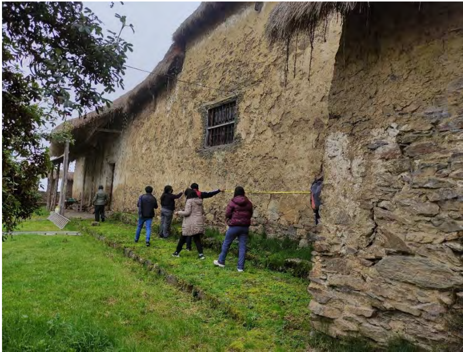
Figura 34 Vista del muro en estudio.
