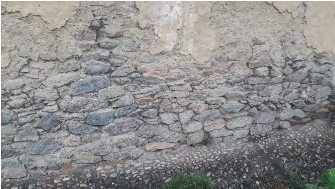
Figura 17 Muro del templo San Francisco de Asís
