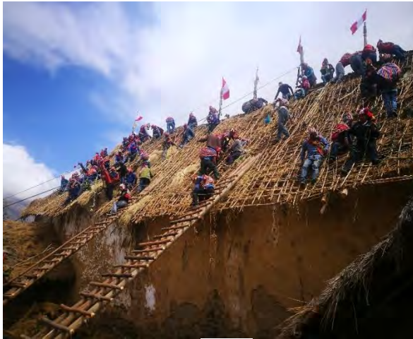
Figura 31 Colocación de enmallado del techo.
