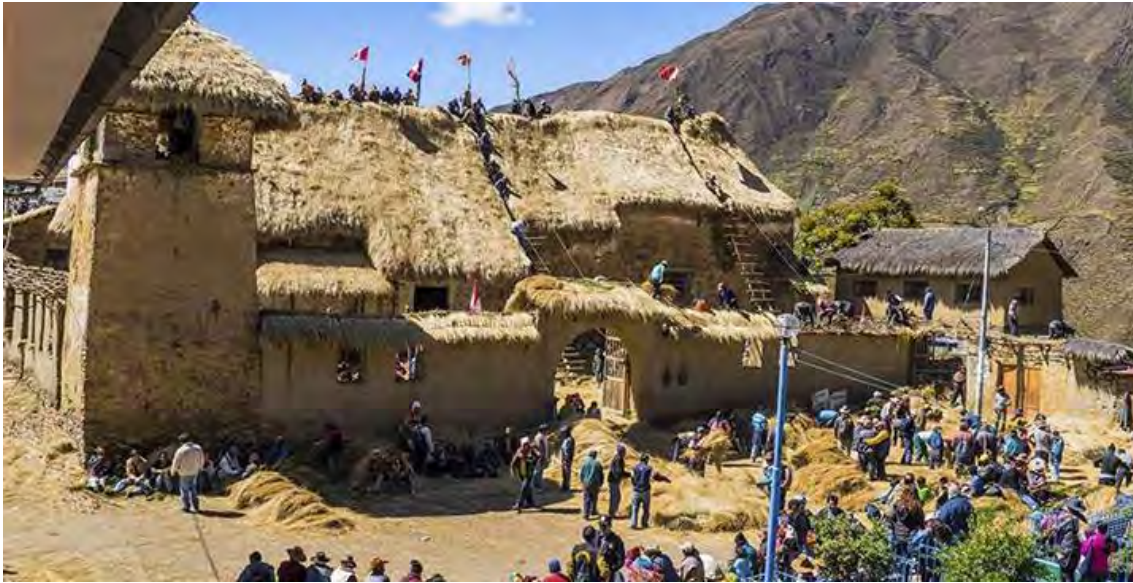
Figura 8 Repaje tradicional del techo
