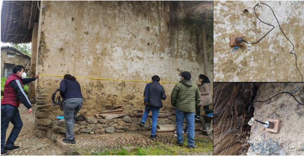
Figura 37 Instalación de acelerómetros
