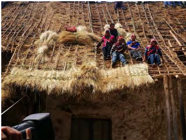
Figura 32 Colocación de Ichhu en el techo.
