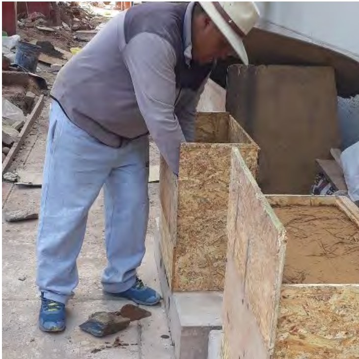
Figura 18 Encofrado para asentado de muro de albañilería
