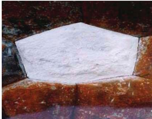
Figura 13: Proceso de empaste con solución de cal, \text{Ca}(\text{OH})_2 1999
