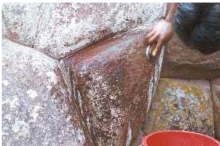
Figura 15: Limpieza mecánica. 1999
