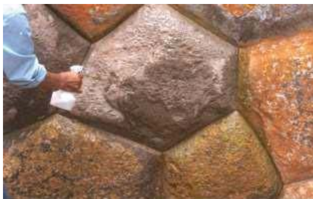
Figura 18: Proceso de aplicación del biosida TEGO HB. 1999
