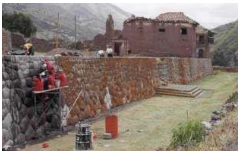
Figura 16: Liberación y limpieza de líquenes. 1999
