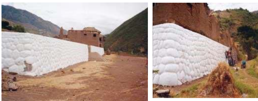
Figura 17: Aplicación de papetas para la desalinización, 1999
