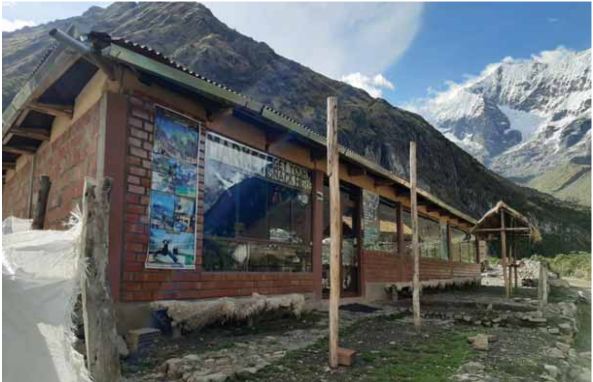
Fotografía 12. Construcción de restaurantes
