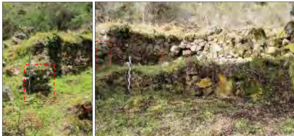
Figura 54. Vano de acceso en el extremo noroeste de la estructura B-09 y contiguo a un espacio abierto. Fuente: Propia
