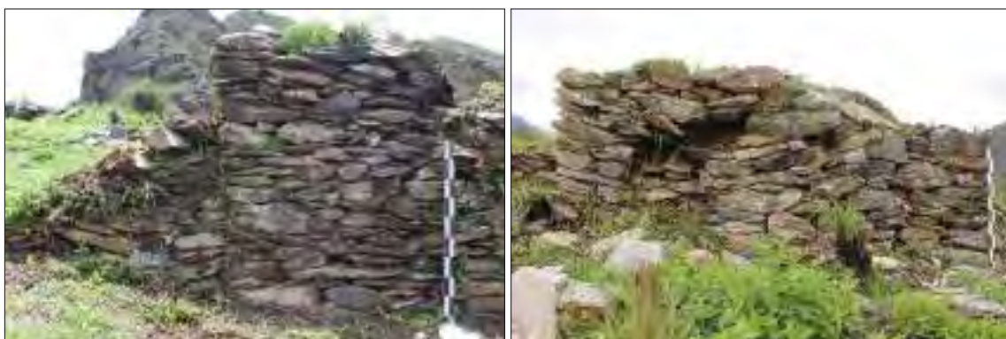
Figura 105. Detalle del paramento interno de las estructuras "E-01" y "E-07" compuestos por lajas de diferentes tamaños que muestran inclinación hacia el interior. Fuente: Propia
