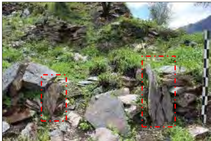
Figura 115. Detalle del vano de acceso orientado hacia el oeste y que conecta a un espacio abierto, estructura 04-Juchuy Poques. Fuente: Propia
