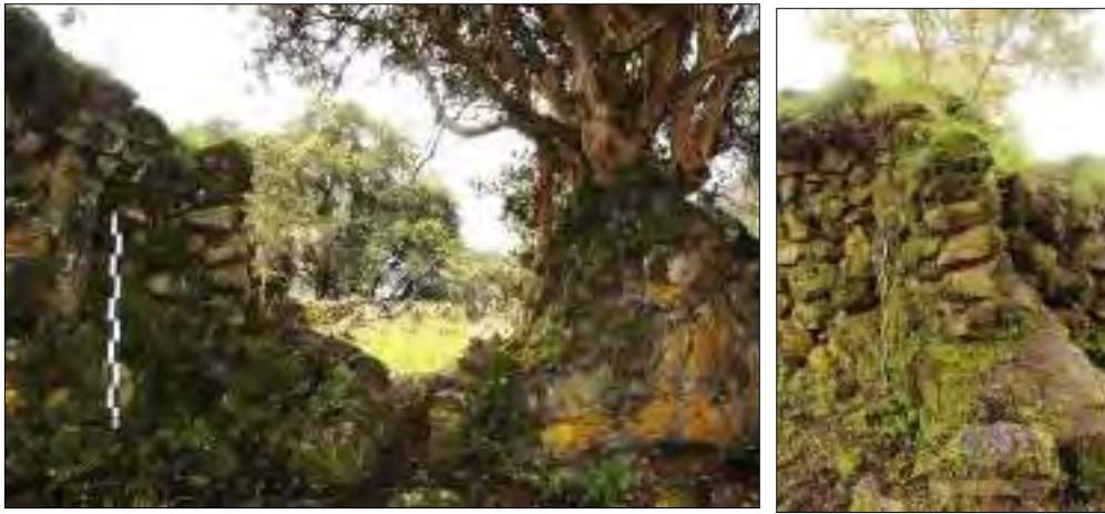
Figura 71. Vano de acceso en el extremo oeste de la estructura C-02. Fuente: Propia
