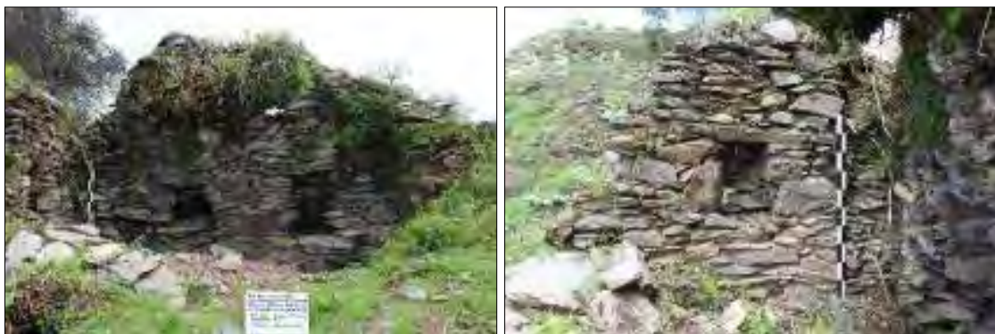
Figura 108. Detalle de las tres hornacinas ubicadas en el paramento interno de muro norte y oeste, estructura 01- Juchuy Poques. Fuente: Propia
