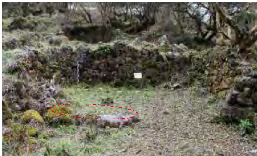
Figura 41. Vista panorámica de la estructura A-01, se observa la proyección de una hilada de piedras y el espacio abierto (patio). Fuente: Propia.
