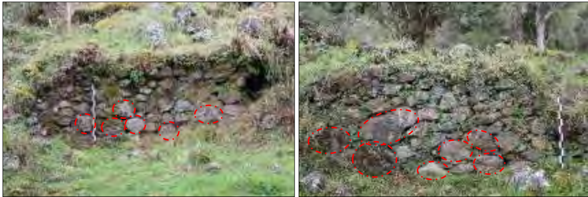
Figura 47. Detalle de los mampuestos de mayor dimensión en la base de los muros, estructura A-08. Fuente: Propia
