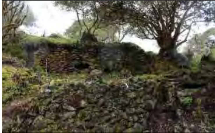
Figura 69. Vista panorámica de la plataforma y de la estructura C-02. Fuente: Propia
