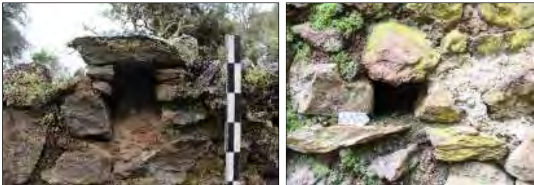
Figura 95. Detalles de las hornacinas dispuestos en los paramentos internos de las estructuras A-02 y C-02 respectivamente. - Jatun Poques. Fuente: Propia
