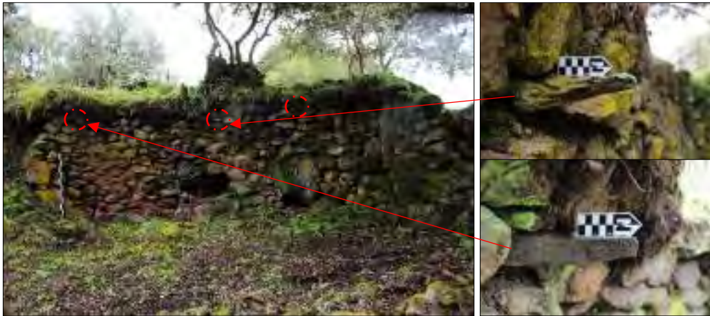
Figura 92. Disposición de las clavijas de la estructura C-02 y detalle de la clavija que sobresale del muro próximo a la cabecera-Jatun Poques. Fuente: Propia
