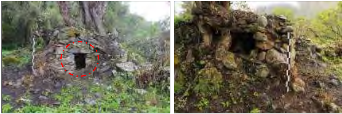
Figura 78. Detalle del vano de acceso y detalle del colapso de la estructura C-07. Fuente: Propia
