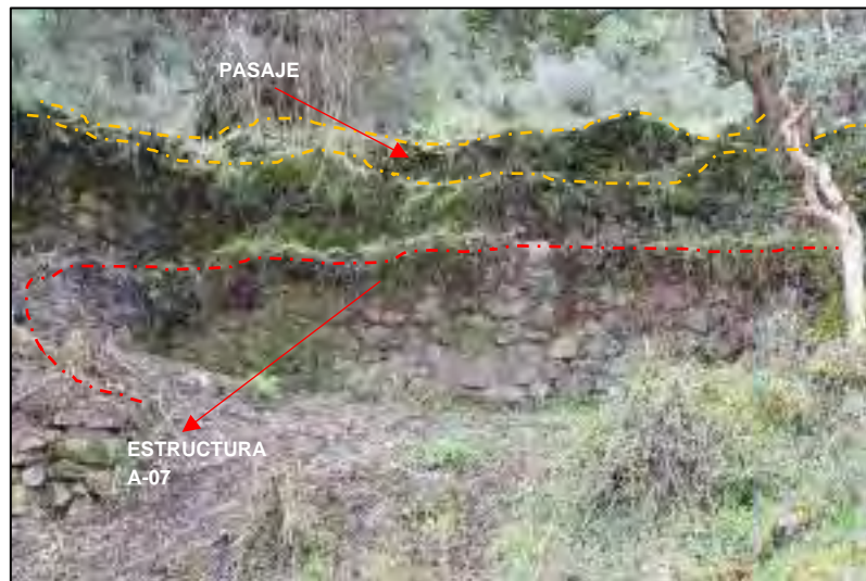
Figura 43. Estructura A-07 delimitado por un muro de sostenimiento de terraplén y talud. Fuente: Propia
