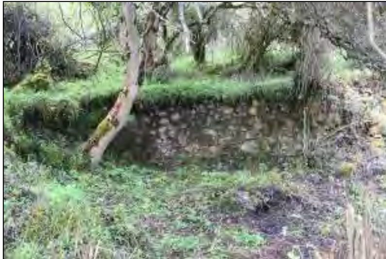
Figura 53. Vista panorámica de la estructura B-03. Fuente: Propia
