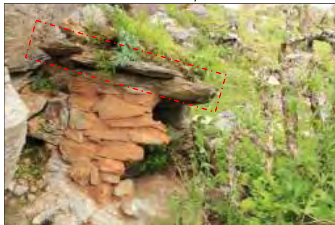
Figura 107. Detalle de cubierta de falsa bóveda y cornisa de la estructura funeraria 03 – Juchuy Poques. Fuente: Propia
