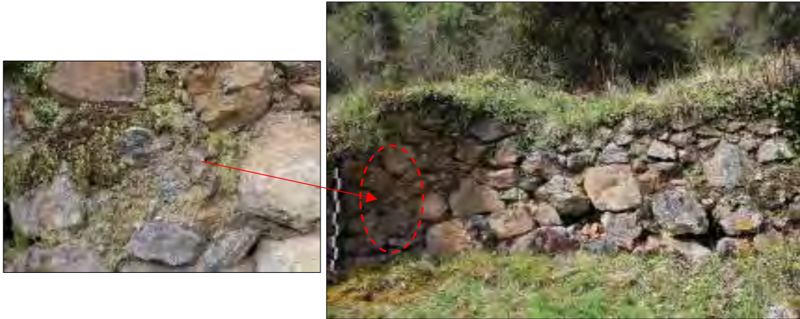
Figura 135. Detalle del revoque en el paramento interno de la estructura B-05 en el sitio de Jatun Poques. Fuente: Propia
