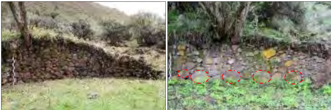
Figura 98. Distribución de piedras sin orden de hiladas y mampuestos de mayor dimensión en la base de los muros, estructura A-05 y B-01 respectivamente. Fuente: Propia
