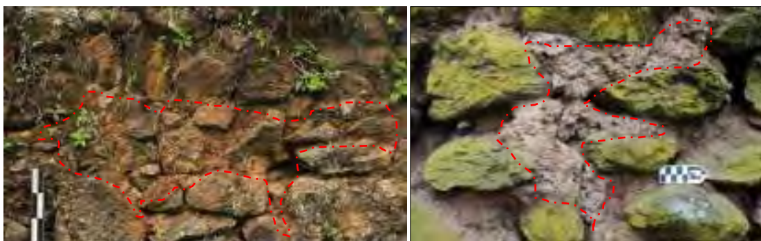
Figura 97. Detalle del paramento interno estructura A-02 y C-04 respectivamente, donde se evidencia argamasa de tierra arcillosa de color marrón y restos de revoque. Fuente: Propia
