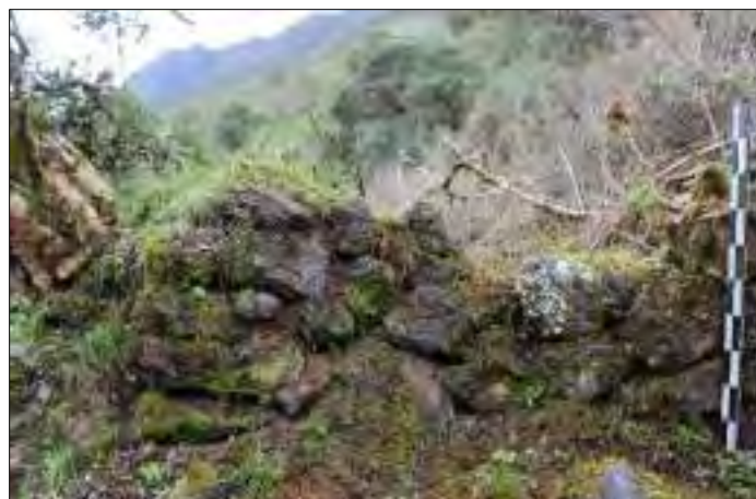
Figura 61. Detalle de los mampuestos de mayor dimensión en la base de los muros, estructura B-08. Fuente: Propia
