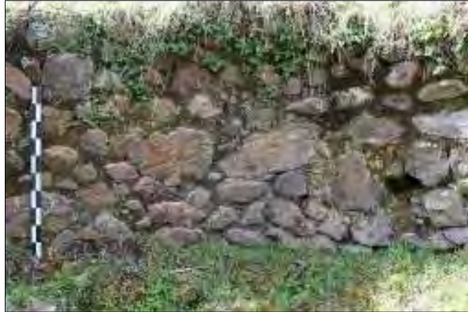
Figura 90. Sección de muro de mampostería ordinaria (rustico) constituida por elementos líticos de diferentes dimensiones. Fuente: Propia
