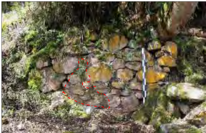
Figura 65. Vista de muro de la estructura B-06 donde se evidencia argamasa de tierra arcillosa de color marrón y restos de revoque. Fuente: Propia
