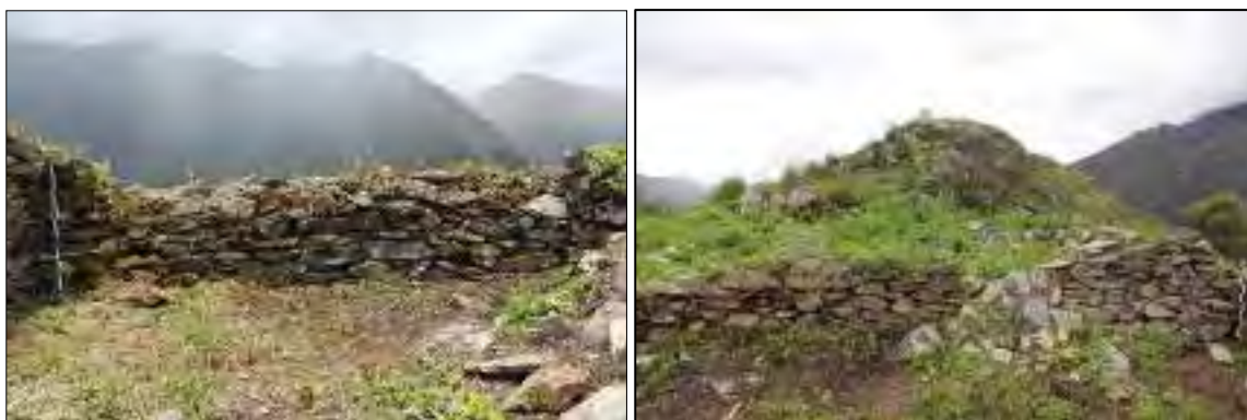
Figura 103. Muro continuo de las estructuras "E-03" y "E-07" respectivamente. Fuente: Propia
