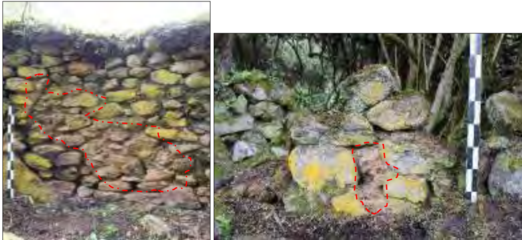
Figura 74. Detalle de restos de revoque en el paramento interno de las estructuras C-02 y C-05. Fuente: Propia
