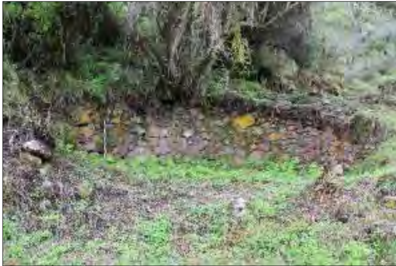
Figura 51. Vista panorámica de la estructura B-01, en relación al espacio. Fuente: Propia.
