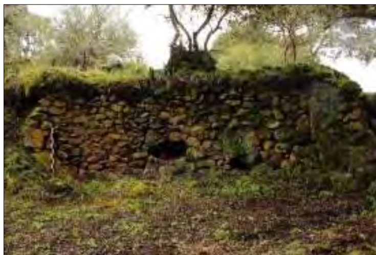
Figura 73. Detalle del paramento interno de la estructura C-02. Fuente: Propia
