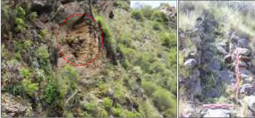
Figura 123. Sección de muro del canal prehispánico adosado al afloramiento rocoso y sección del canal que atraviesa el sitio de Juchuy Poques, este canal se encuentra cerca a los andenes de Ancopacha. Fuente: Propia
