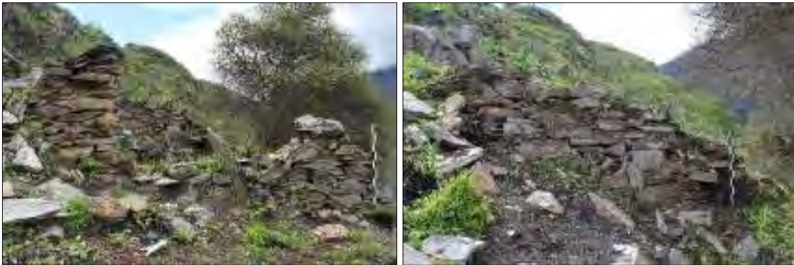
Figura 114. Evidencia del alineamiento de piedras del paramento interno, estructura E-06- Juchuy Poques. Fuente: Propia
