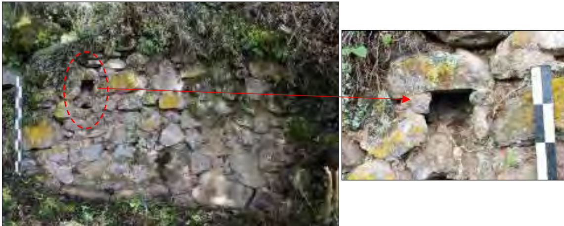
Figura 64. Detalle del paramento interno donde se evidenció una hornacina pequeña, estructura B-06. Fuente: Propia
