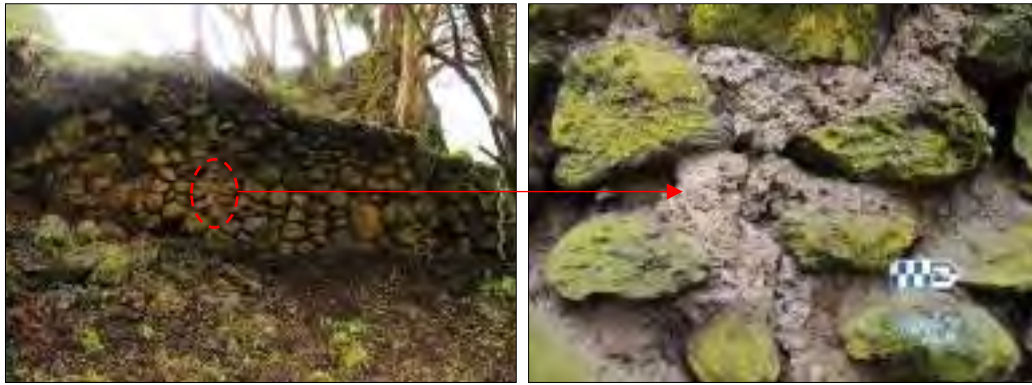
Figura 82. Detalle de restos de revoque de la estructura C-04. Fuente: Propia
