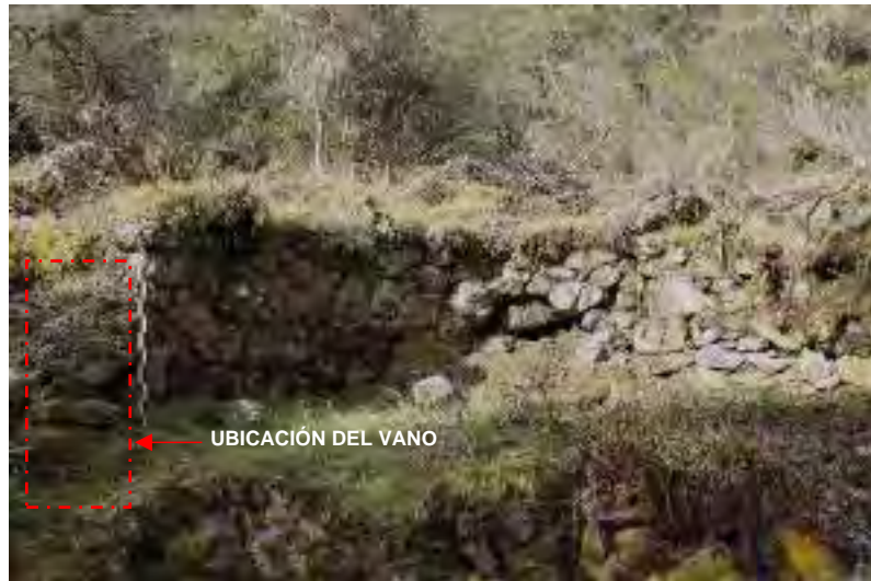
Figura 93. Detalle del Vano de acceso de la estructura B-09 ubicado en la esquina noroeste del recinto. Fuente: Propia
