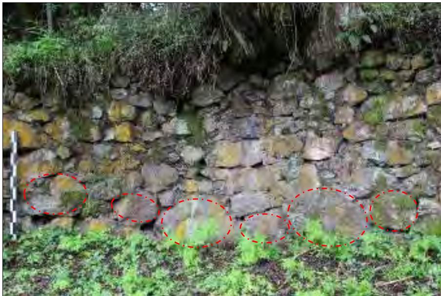
Figura 56. Detalle de los mampuestos de mayor dimensión en la base de los muros, estructura B-01. Fuente: Propia
