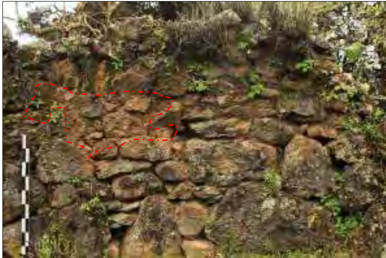
Figura 39. Restos de revoque evidenciado en el paramento interno de la estructura A-02. Fuente: Propia
