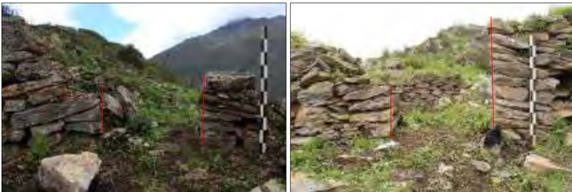
Figura 125. Vano de acceso de las estructuras 05 y 07 -Juchuy Poques. Fuente: Propia
