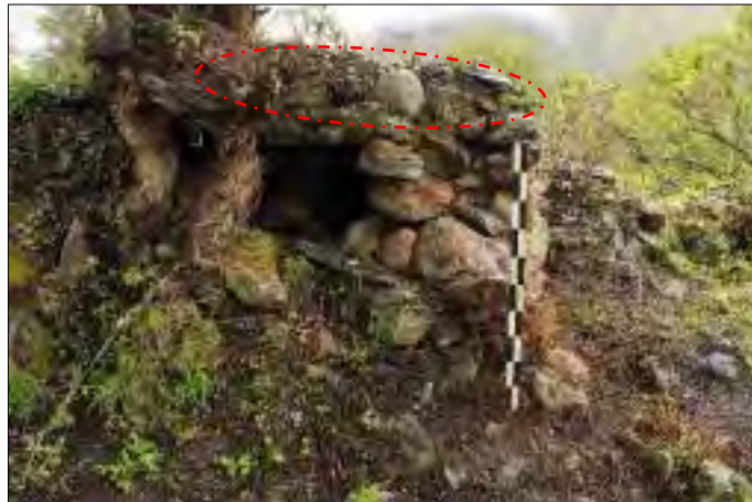
Figura 91. Cubierta falsa bóveda, Estructura C-07.-Jatun Poques. Fuente: Propia
