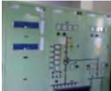
Figura 4 - Ejemplo tableros mímicos parte BT de una SET
