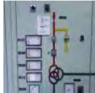
Figura 5 - Ejemplo tableros mímicos parte MT de una SET
