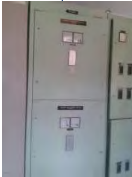
Figura 56 - Cargadores-rectificadores 220 VDC y 48 VDC.
