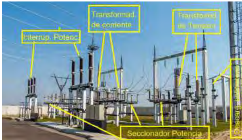
Figura 12 - Ejemplo de Equipos primarios a modelar
