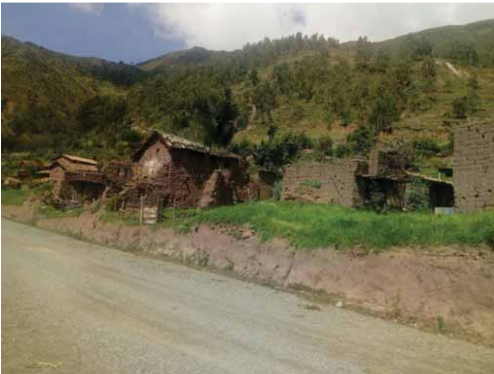
Vivienda colapsada en la comunidad
