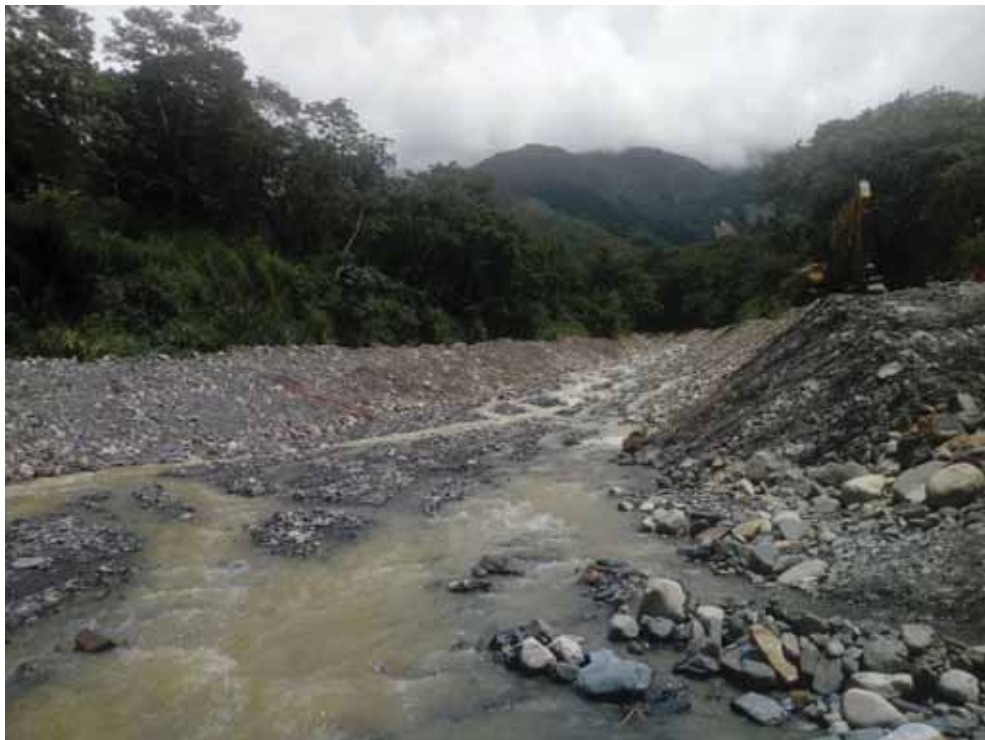
Descolmatación de río Sicre
