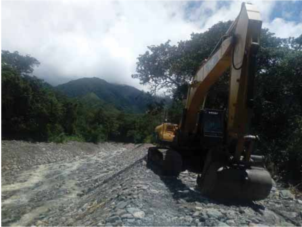
Descolmatación de río Sicre
