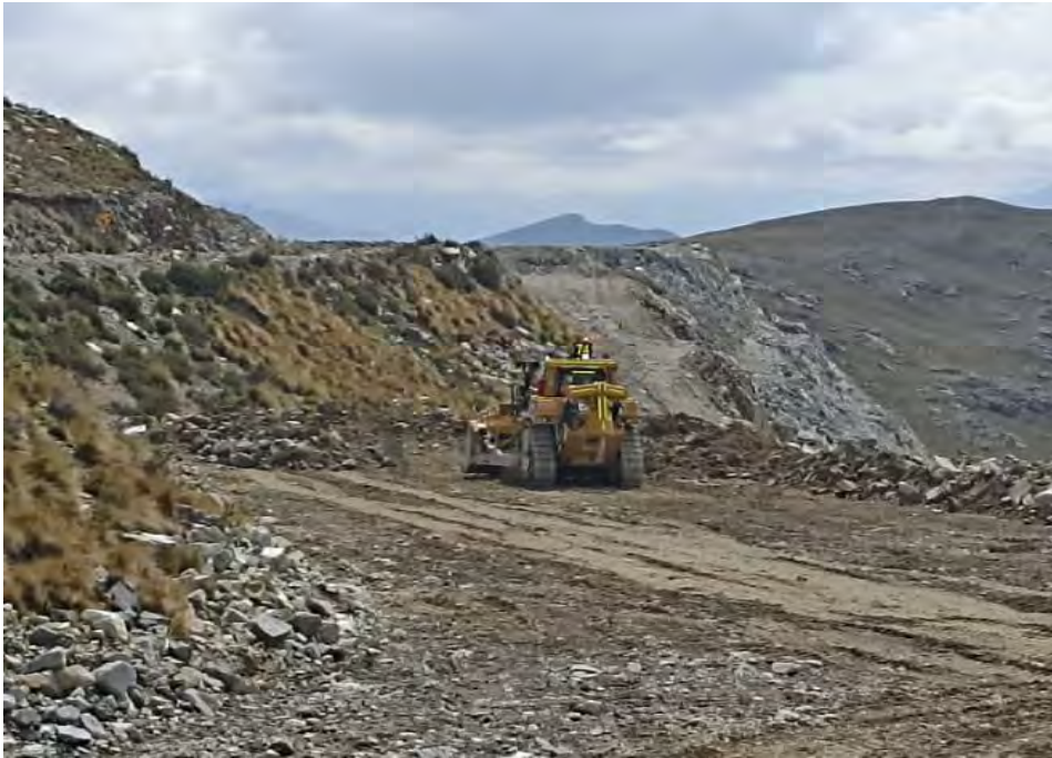
Imagen 12: Bulldozer CAT Aperturando accesos
