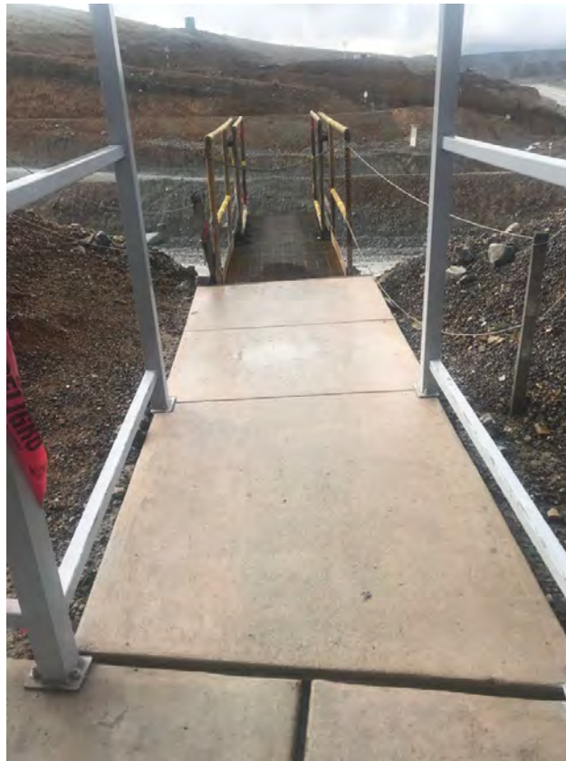
Imagen 23: Zona de espera de la bahía de cambio en caliente
