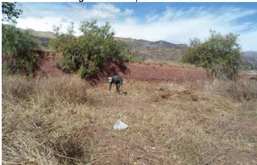
Fotografía 02. Limpieza del terreno
