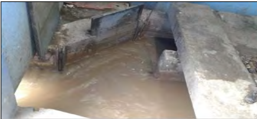
Cámara de llegada de la PTAR Sicuani
