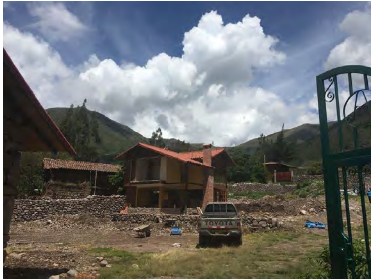
Imagen 3 - Vivienda en construcción para alquiler
