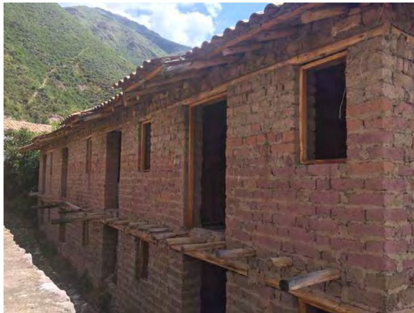
Imagen 8- Vivienda en construcción para alquiler
