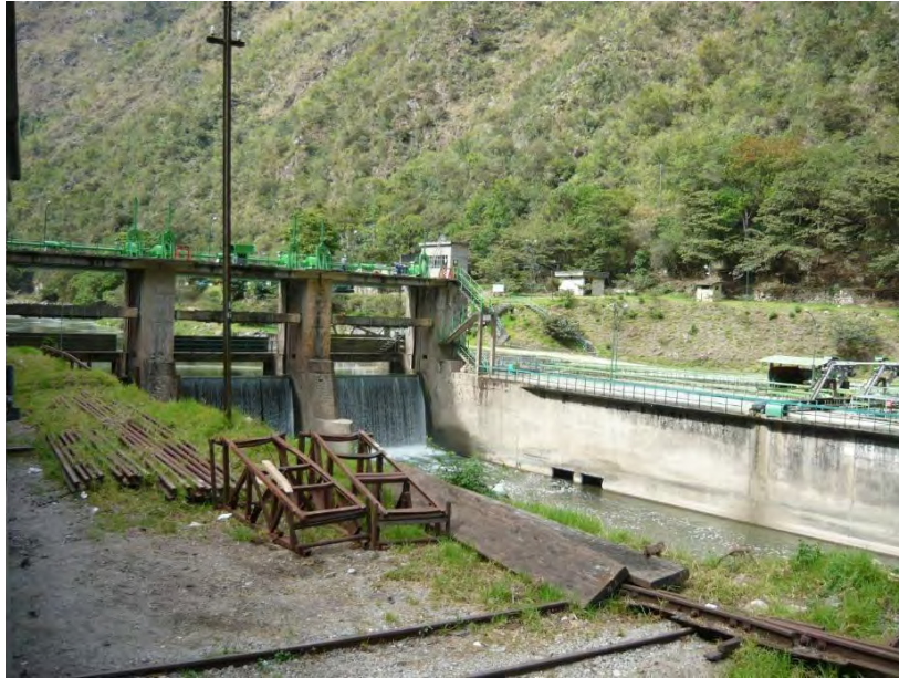
Foto N° 09: Central de Hidroeléctrica de Machupicchu
