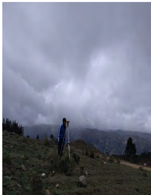
Fotografía 3-6: Nivelación en el pico más alto. (Tesista)
