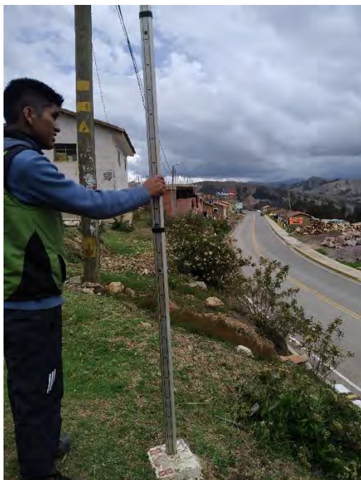
Fotografía 3-5: Inicio de traslado de cota. (Ayudante)
