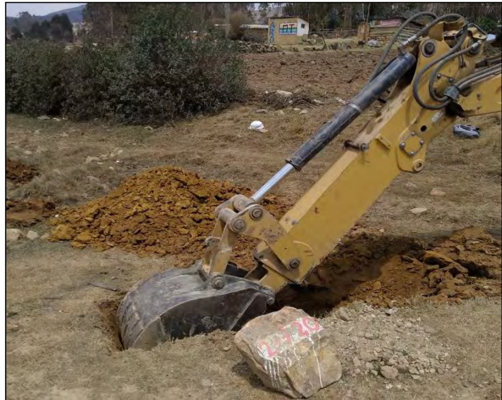
Fotografía 3-15: UBICACIÓN CALICATA N° 03 KM:02+720 -SALIDA CENTRO POBLADO MIKA.
