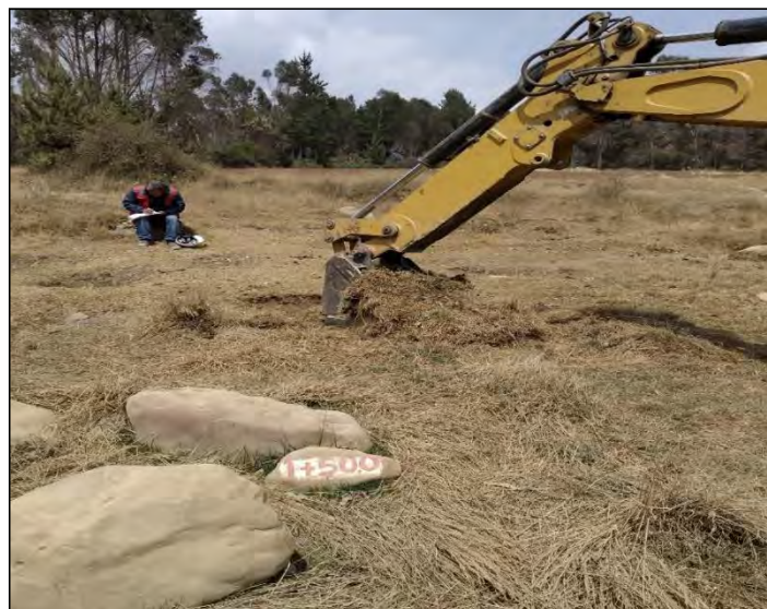
Fotografía 3-13: UBICACIÓN CALICATA N° 02 KM:01+500 - ENTRADA CENTRO POBLADO MIKA.
