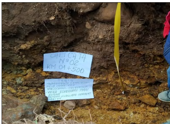
Fotografía 3-14: PROFUNDIDAD DE EXCAVACION 1.60m, SE APRECIA NIVEL FREATICO.CALICATA N°02
