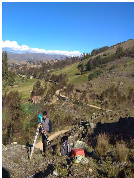
Fotografía 3-2: Instalación de la Estación Total.
