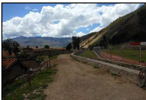
Figura 64: deslizamiento en las faldas del cerro Wilcacalli (Fuente: fotografía propia)
