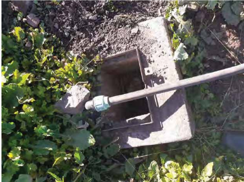
Foto: Hidrante para la captación del riego por asperion
