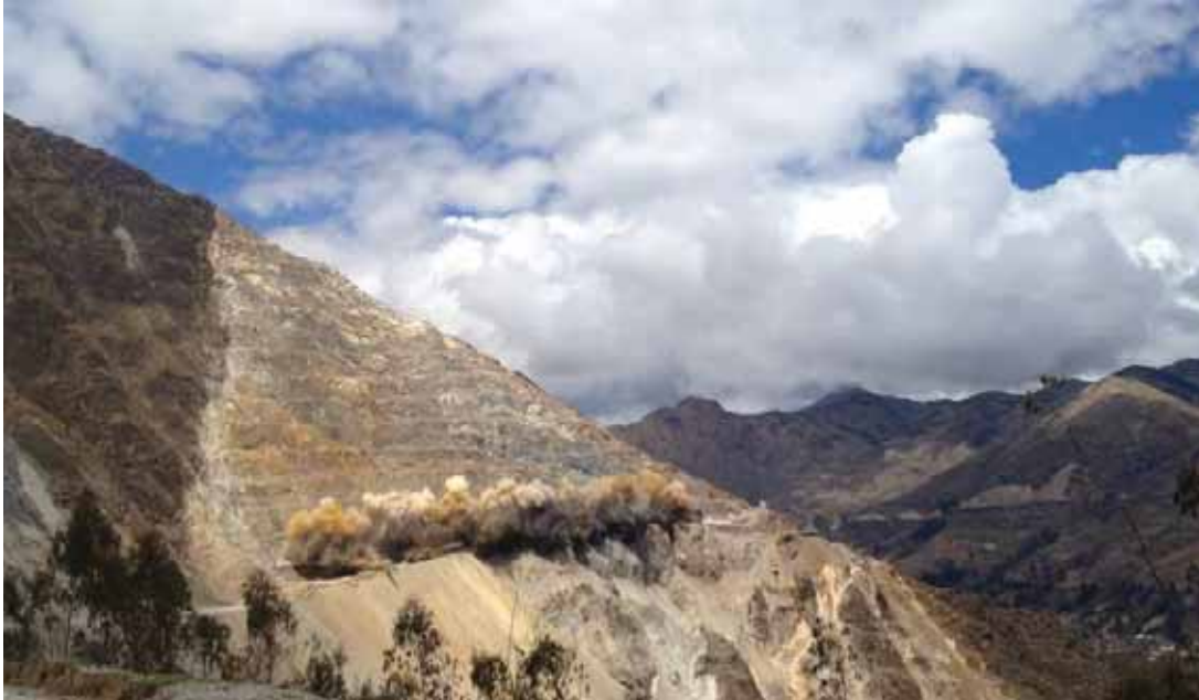
Imagen 2: Voladura en el Sector Crítico de Senseccalla
