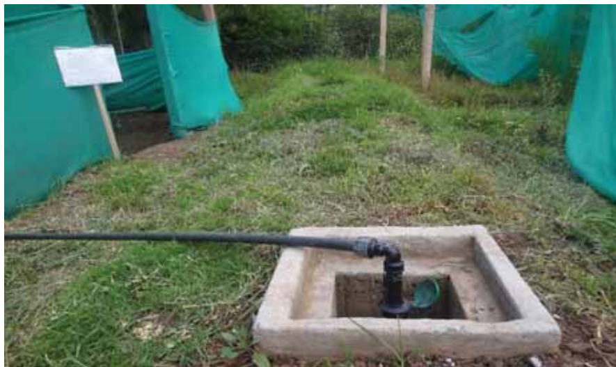
Imagen N°09: Acondicionamiento del sistema de riego de un hidrante.
