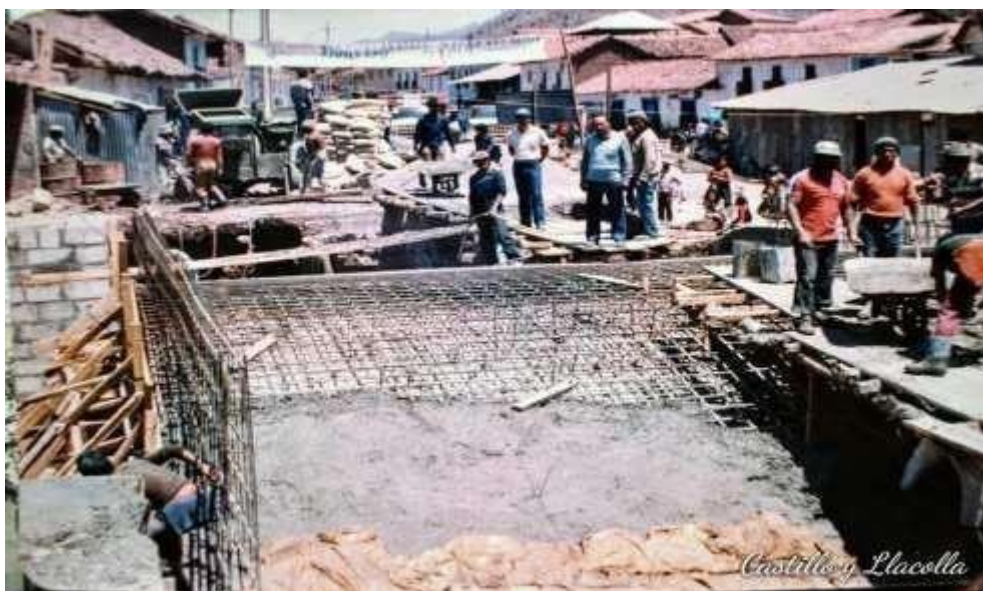
CONSTRUCCION DEL PUENTE DE IZCUCHACA EN LOS AÑOS 80
