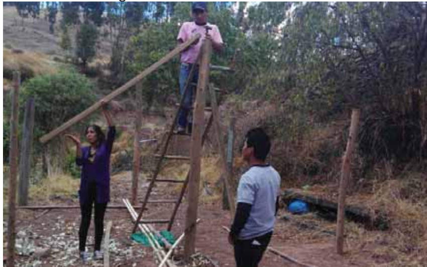
Fotografía 4: Construcción del fitotoldo
