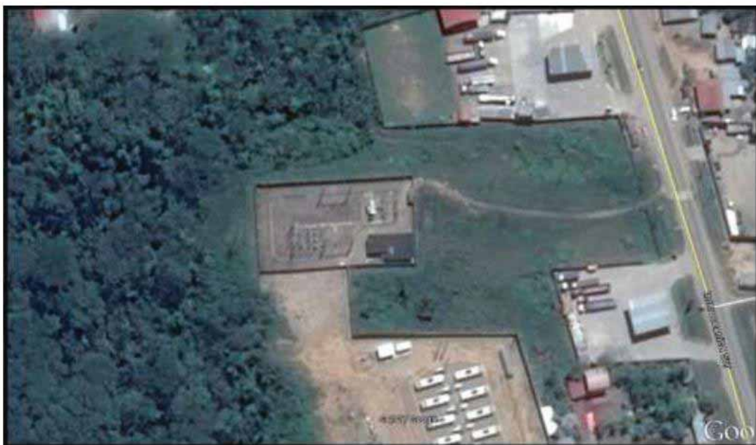
Figura 30: imagen Satelital de la subestación de Puerto Maldonado
