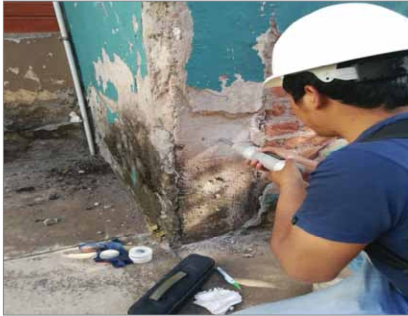
Figura 10: Ensayo de esclerometría en columna de primer nivel. (Fuente: Elaboración propia).
