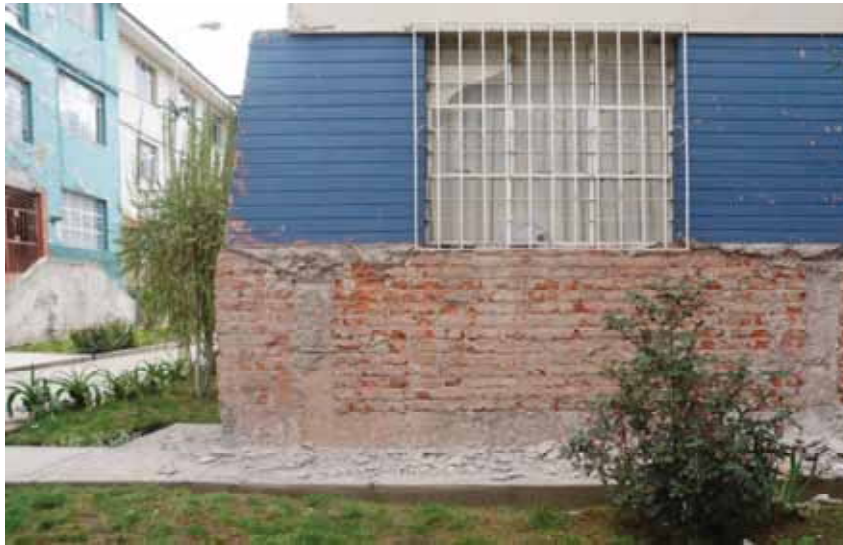
Figura 5.1-1 Refacción de fachadas en los edificios del conjunto vecinal Zarumilla.
