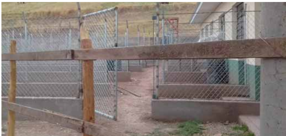
Fotografía 1: Instalación para sistema de crianza semi intensivo
