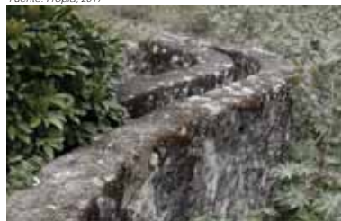
FIGURA 232: Vista Perspectivada del Acueducto - Molino Fuente: Propia, 2017
