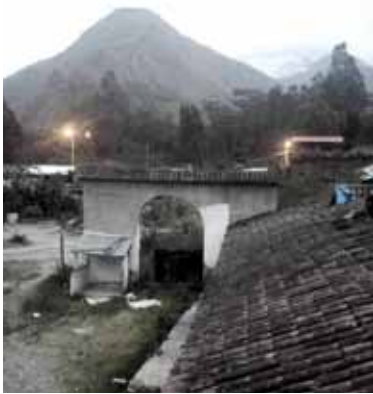
FIGURA 237. Cobertura de teja artesanal de la Época Contemporánea Fuente: Propia, 2017
