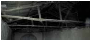
FIGURA 236: Estructura de Tijeral provisional en la Nave - Capilla Fuente: Propla, 2017
