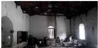
FIGURA 240: En el Trapiche se observa estructura provisional con cobertura de colamina - Molino Fuente: Propia, 2017
