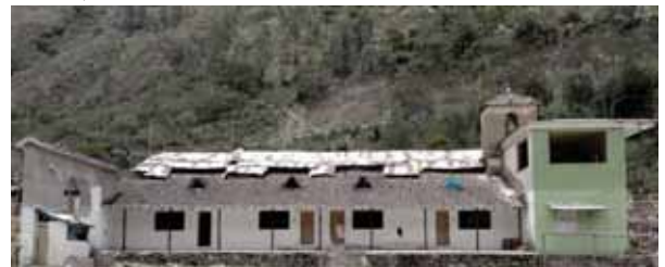
FIGURA 230: Vista Lateral Izquierda del Inmueble - Capilla Fuente: Propia, 2017
