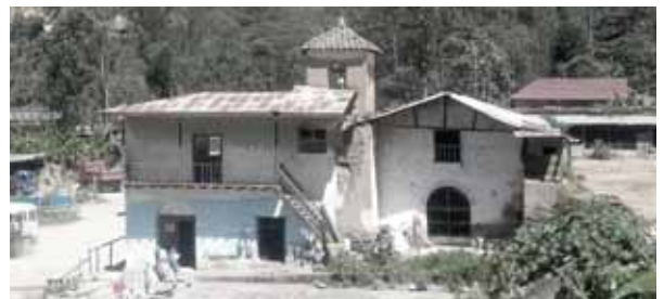
FIGURA 227: Vista Frontal del Inmueble - Capilla Fuente: Propia, 2017
