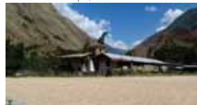
FIGURA 83: Hacienda Huadquiña - Vista Lateral Derecha Fuente: Archivo Propio, 2016.
