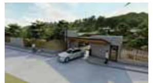
VISTA INGRESO DE SERVICIO
