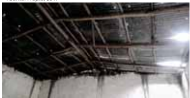
FIGURA 241: En la Falca se tiene tjerates provisionales con cobertura de colamina. Fuente: Propia, 2017
