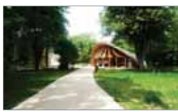
FIGURA 146: Ingreso Principal. Fuente: ArchDaily, 2012
