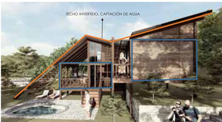
FIGURA 196: Techo Invertido Fuente: Propia, 2017
