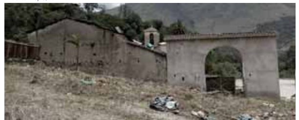
FIGURA 233: Vista Posterior del Inmueble - Capilla Fuente: Propia, 2017
