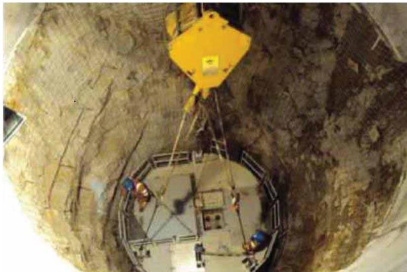
La unidad minera Animón, los primeros 30 metros de avance de excavación, los realizó de manera manual, luego de ello realizó la limpieza del collar de pique con la plataforma de trabajo Galloway y el equipo Cryderman. El modelo de Cryderman utilizado fue Herman y para su izaje se utilizó un winche que se instaló en el Galloway; además el Cryderman se utilizó para el carguío de los baldes de profundización.
