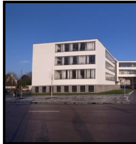
IMAGEN 130: Utilización de Placas de Concreto Armado para Bloques de Mayor Altura. FUENTE: Imagen Propia.
