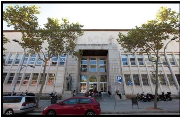
IMAGEN 16: Fachada Principal. FUENTE: Universidad de Barcelona. Facultad de Bellas Artes. http://www.ub.edu/bellesarts/
