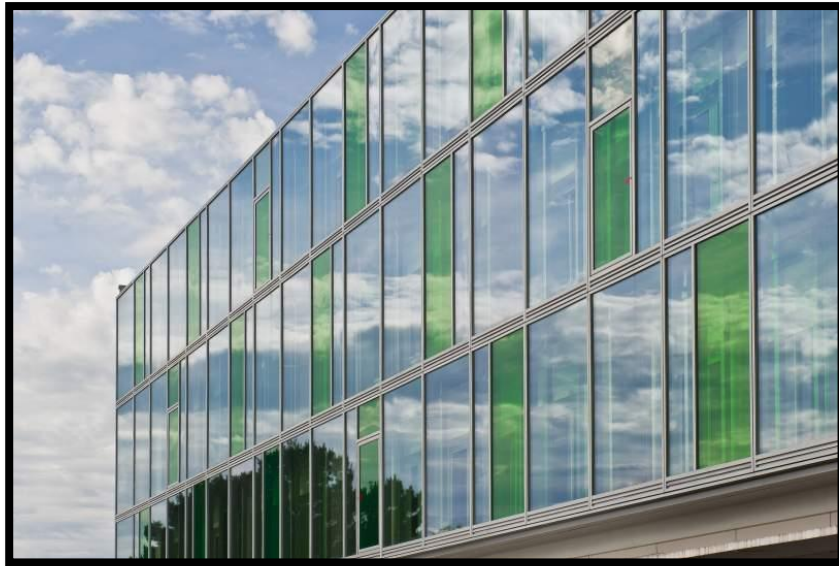
IMAGEN 132: Vanos para Iluminación y Ventilación. FUENTE: Imagen Propia.
