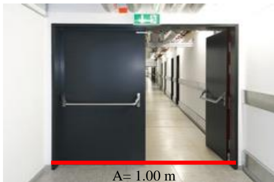
IMAGEN 61: Ancho mínimo puertas de evacuación 1.00 m.
