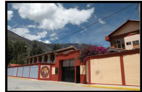
IMAGEN 57: Fachada ESABAC – Sede Calca. Fuente: Imagen Propia.
