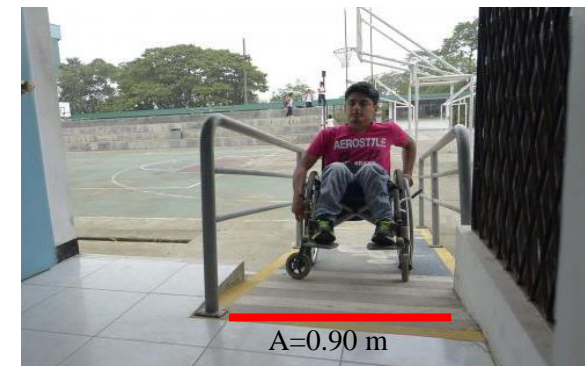
IMAGEN 63: Ancho mínimo rampas 0.90 m.
