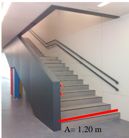
IMAGEN 64: Ancho mínimo escalera de evacuación 1.20 m
