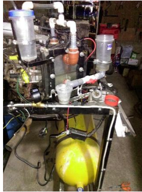
Fotografía 37. Prueba de Hermeticidad a la Instalación de GNV.
