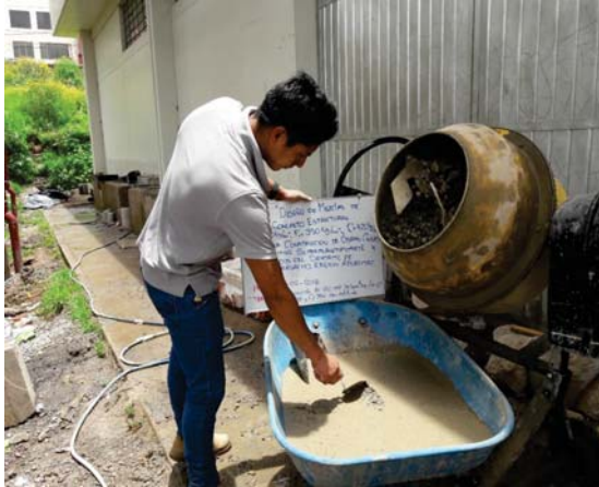
VACIADO DE BRIQUETAS DE CONCRETO f'c=280\text{ Kg/cm}^2 CON ADITIVO SUPERPLASTIFICANTE AL 0.75%.
