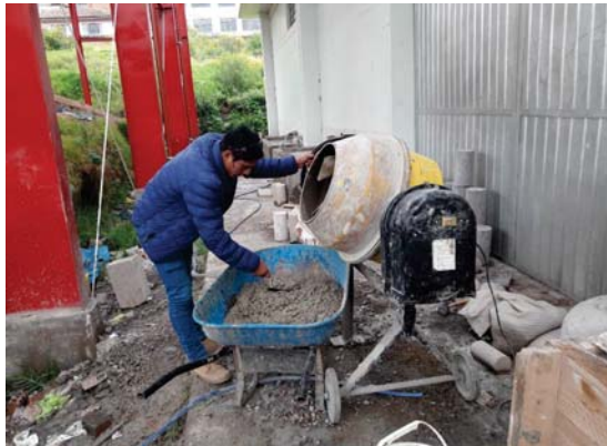
VACIADO DE BRIQUETAS DE CONCRETO F'c=280 \text{ Kg/cm}^2
