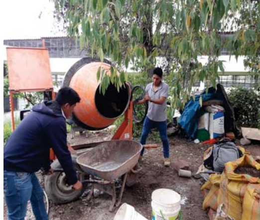
VACIADO DE BRIQUETAS DE CONCRETO PATRON F'c=350\text{ Kg/cm}^2 .
