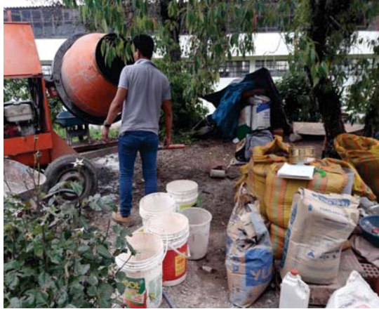
VACIADO DE BRIQUETAS DE CONCRETO PATRON F'c=420\text{ Kg/cm}^2 .
