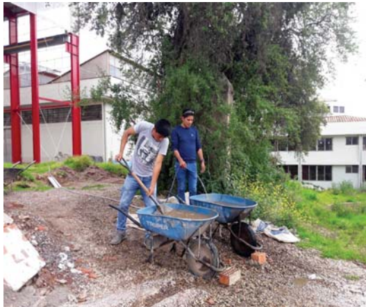
LAVADO DE AGREGADO FINO
