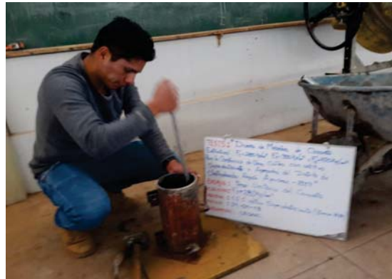
ENSAYO DE PESO UNITARIO DEL CONCRETO FRESCO.
