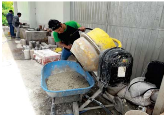
VACIADO DE BRIQUETAS DE CONCRETO F'c=280 \text{ Kg/cm}^2
