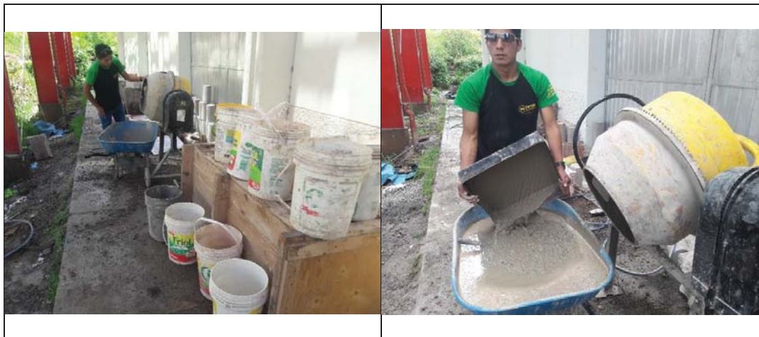
Imagen 3.13. Mezcladora de 80lt de capacidad
