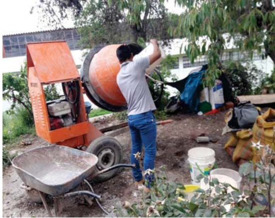
VACIADO DE BRIQUETAS DE CONCRETO PATRON F'c=280 \text{ Kg/cm}^2 .
