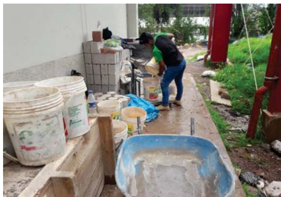
VACIADO DE BRIQUETAS DE CONCRETO F'c=350\text{ Kg/cm}^2
