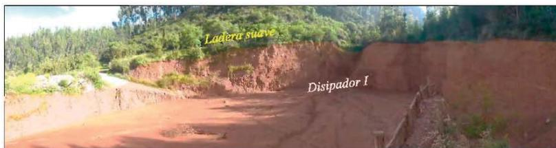
Figura 10 Se muestra ladera suave, ubicada en el lado derecho del disipador I, además se observa la densidad de la vegetación manteniendo el talud estable.
