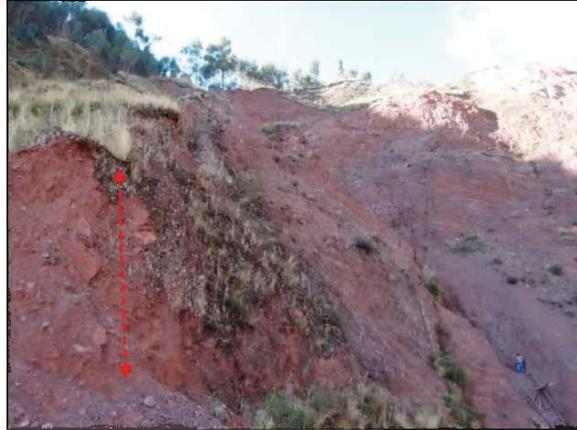
*Se observa la parte intermedia del talud Picol, se aprecia a lado izquierdo banco de materiales coluviales que han sido producto de los deslizamientos inactivos cuya potencia alcanza los 2.00m., además tiene una cobertura vegetal rala*
