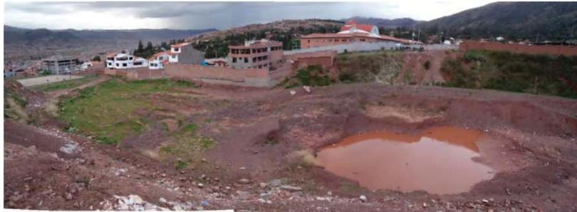
Figura 51 Disipador 2, se puede apreciar el agua estancada y rastros de material que ya ha sido retirado.
