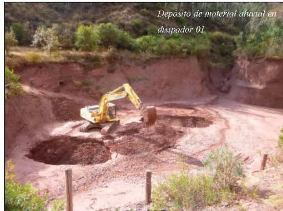
Figura 26 Se muestra depósito de material aluvial, conocida también como disipador 01, compuesta por gravas, arenas y finos.
