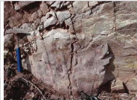
Esta imagen fue tomada en la parte superior del talud Pícol a la altura de la corona del deslizamiento Pícol, en el cual se puede apreciar el espejo de falla normal con una orientación de buzamiento de 70°SO, además de esta existen algunos sistemas de fracturas que cortan de forma transversal, donde estas debilitan aún más el macizo rocoso de tipo areniscas feldespáticas.
