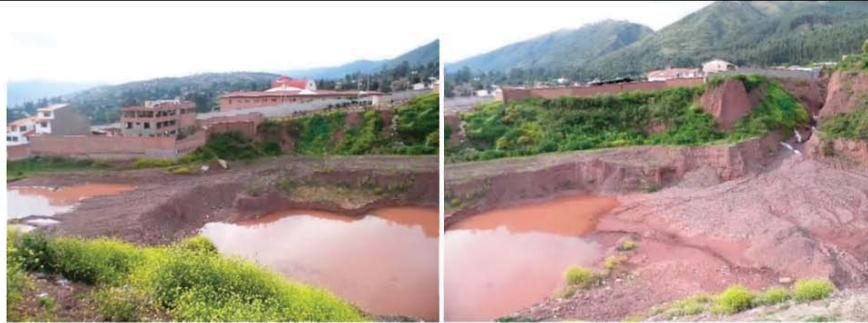
Parte baja de la quebrada Thuniyoc, observando la zona de acumulacion de los materiales de los flujos de detritos, este sector considerado como disipador 02, donde el material excedente del disipador 01 discurre hasta este punto para su depositacion final.
