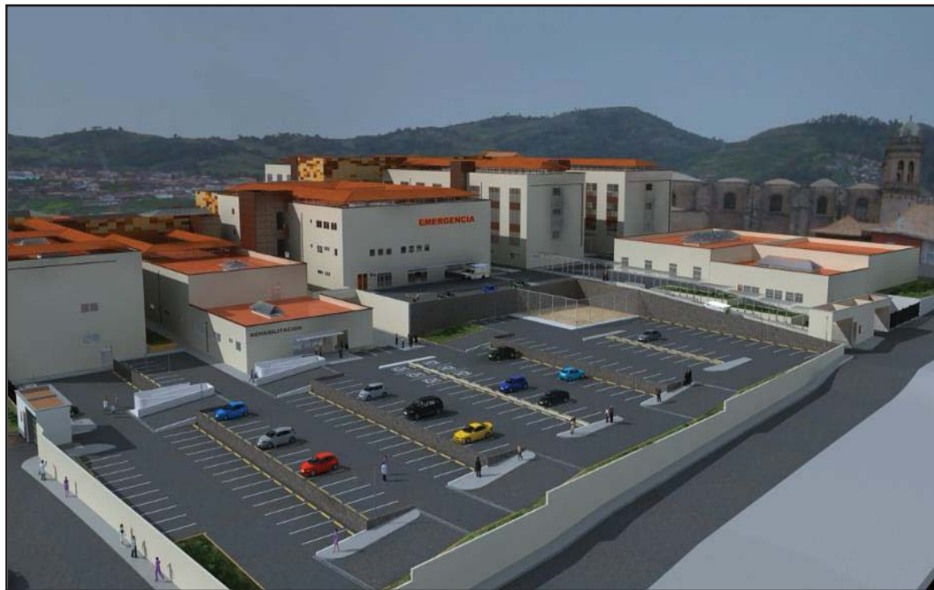
FIGURA 1.2: Vista de la Calle Colca del Hospital Antonio Lorena del Cusco FUENTE: Expediente técnico Hospital Antonio Lorena del Cusco
