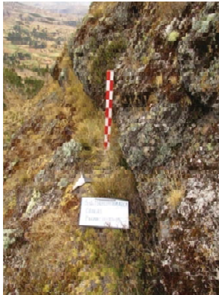
Foto N° 37: Vista de los canales que atraviesan sobre roquedales en pequeños conductos y terrazas agrícolas hacia la parte baja.
