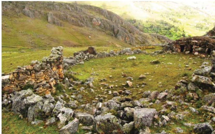
Foto N° 39: Unidad Arquitectónica de aparejo rústico cuyos elementos arquitectónicos están colapsados, en el interior se halla un recinto de planta circular cuyo vano de acceso está orientado hacia el lado Este. (N. Alvino y M. Sarmiento)
