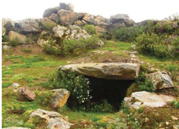
Foto N° 41: Ductos de ventilación, en el interior del recinto R06 (N. Alvino y M. Sarmiento)
