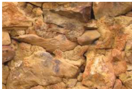
Foto N° 32: Paramento del recinto, se evidencia restos de mortero de arcilla (N. Alvino y M. Sarmiento)
