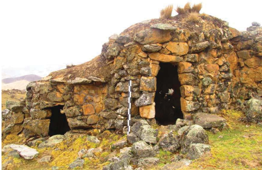
Foto N° 43: Detalle de un recinto de falsa bóveda Rc81 y Rc82 de Machupitumarca, en la parte se la cubierta presentan cornizas de protección y rellenas con tierra (N. Alvino y M.Sarmiento)
