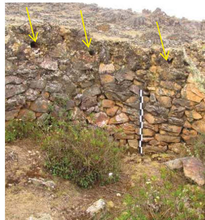
Foto N° 31: Muros de adobe con orificio en las paredes, posiblemente vigas de sostenimiento (N. Alvino y M. Sarmiento)
