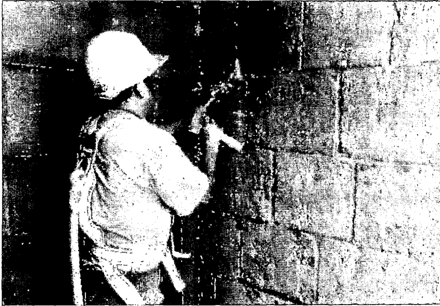
Figura 31. Proceso de extracción de muestra A2: 2) Intervención con cincel y comba
