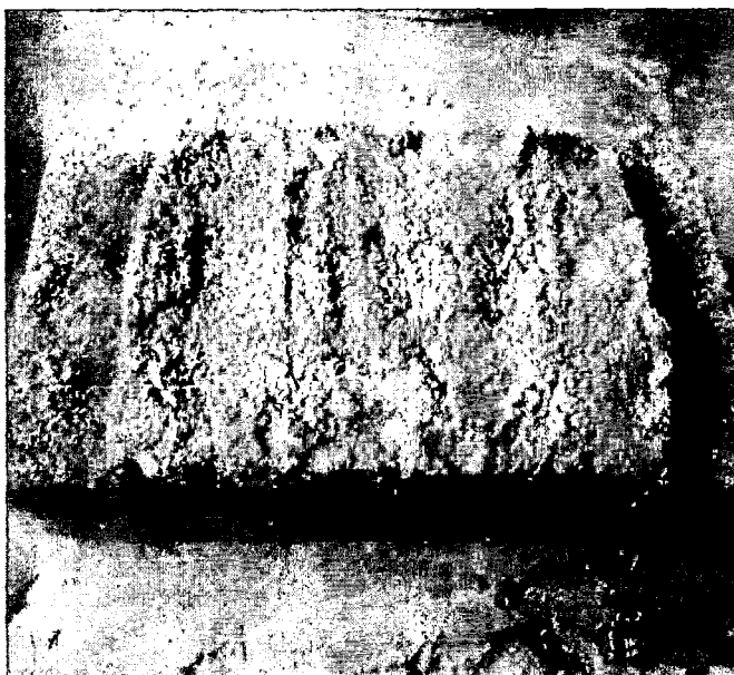
Figura 74. Mortero colocado sobre el bloque de piedra andesita inferior.
