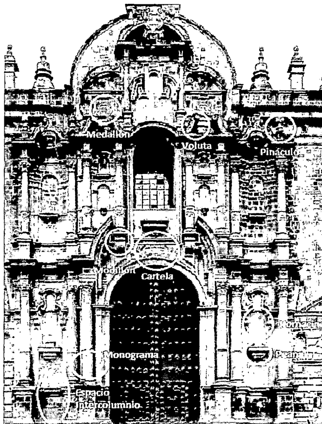
Figura 19. Partes principales de la agrupación "Muros"
