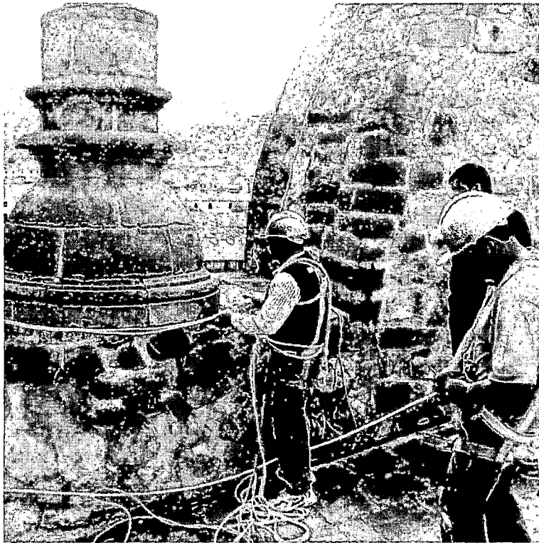
Figura 29. Uso de arneses de seguridad para extracción de muestras parte alta de la Portada Principal de la Catedral de Cusco.
