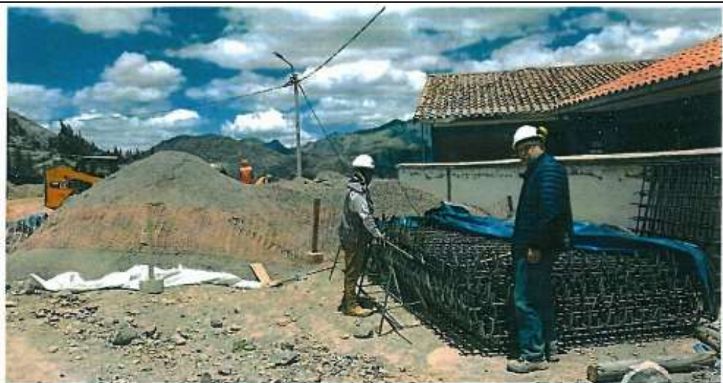
IMAGEN 04. JEFE DE SUPERVISION Y RESIDENTE DE OBRA VERIFICANDO ACERO DE REFUERZO HABILITADO PARA PARRILLAS DE CIMENTACION DE BLOQUE N°02.
