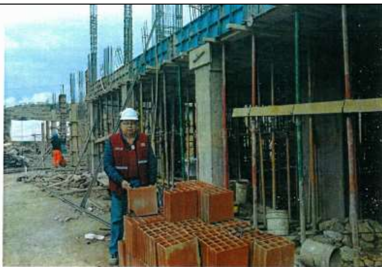
IMAGEN 07. JEFE DE SUPERVISION VERIFICANDO DIMENSIONES DE LADRILLO DE TECHO PARA SU COLOCACION EN LOSA ALIGERADA.
