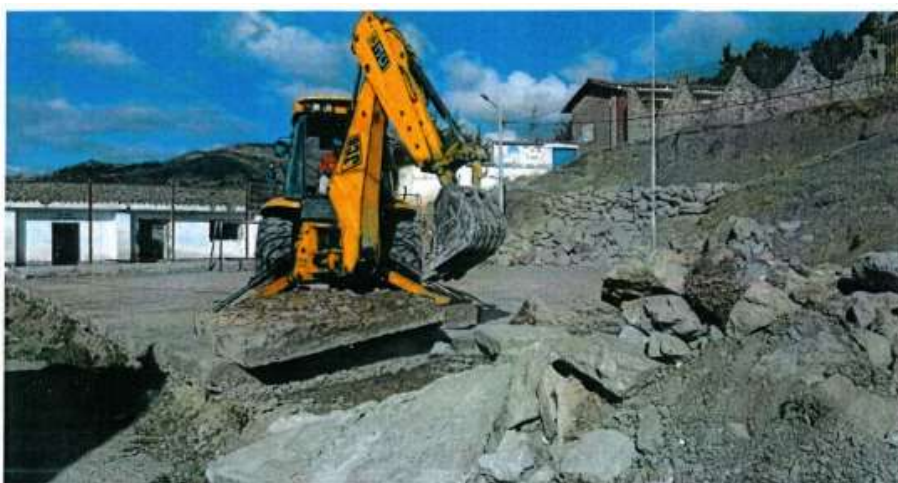
IMAGEN 04. VERIFICACION DE DEMOLICION DE PISOS EXISTENTES CON EQUIPO MECANICO. 1
