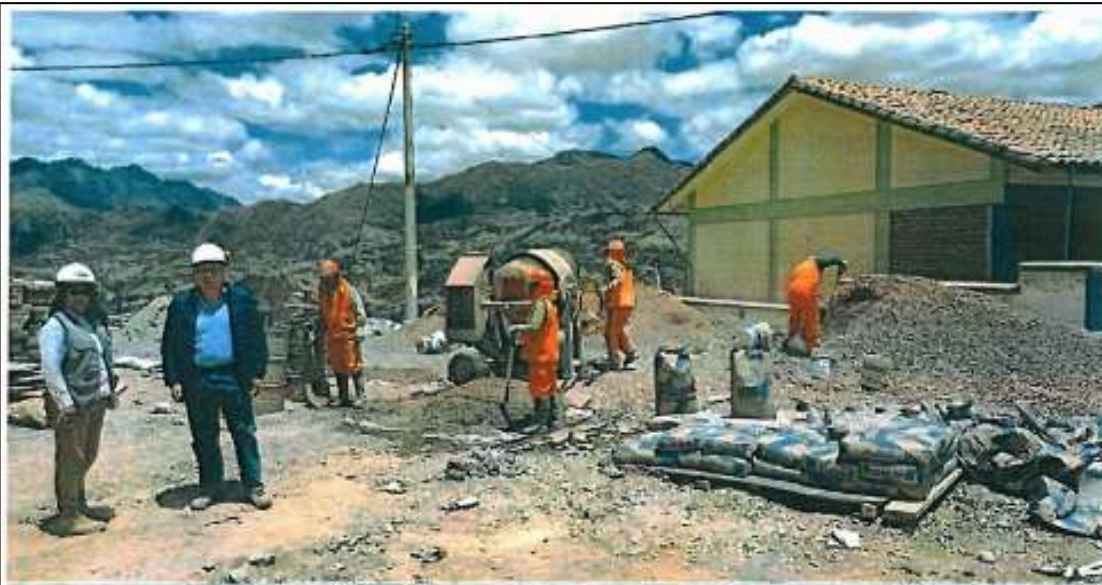
IMAGEN 03. JEFE DE SUPERVISION Y RESIDENTE DE OBRA VERIFICANDO LA PREPARACION DE CONCRETO EN OBRA PARA VACIADO DE SOLADOS.
