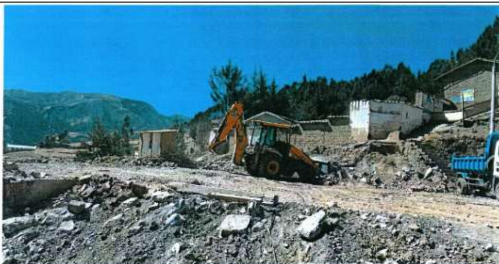
IMAGEN 03. ELIMINACION DE MATERIAL PROVENIENTE DE DEMOLICIONES CON EQUIPO MECANICO, RETROEXCAVADORA Y VOLQUETE.
