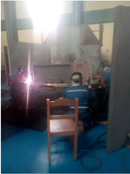
Proceso de reparación mediante soldadura de anillos de estanqueidad de la válvula esférica – Grupo Francis
