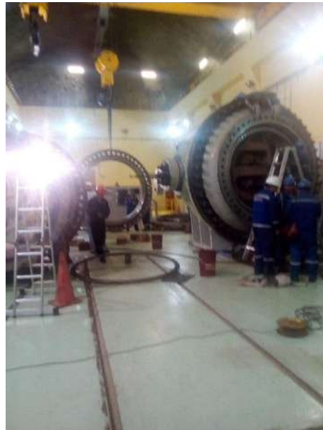
Desmontaje de válvulas esféricas – Grupo Francis
