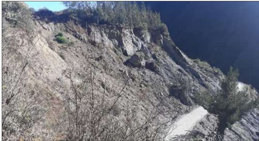
Fotografía 29: Deslizamiento activo con la demarcación de las grietas de coronación y desprendimiento de bloques de material.
