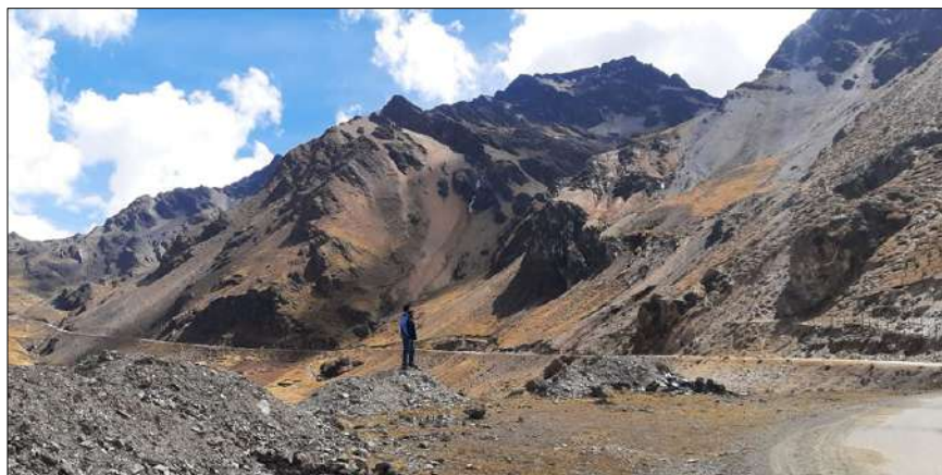
Fotografía 11: Vista panorámica del talud susceptible a deslizamiento, apreciándose los flujos de detritos provenientes de las partes altas Km 01+770 a Km 01+940.
