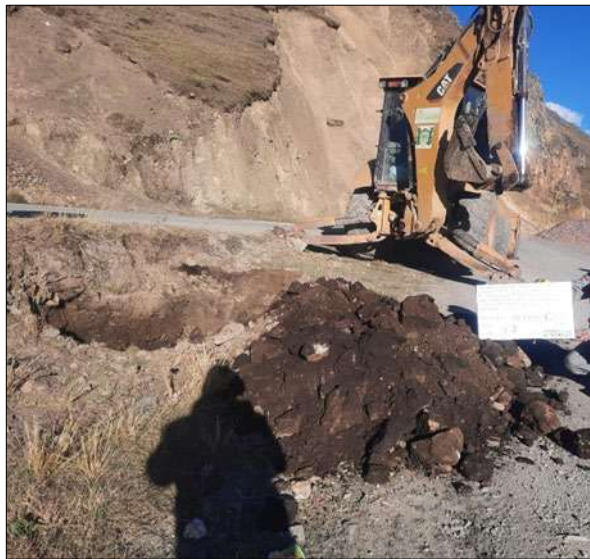
Fotografía 15: Apertura de la Calicata 01 (Km 00+020)
