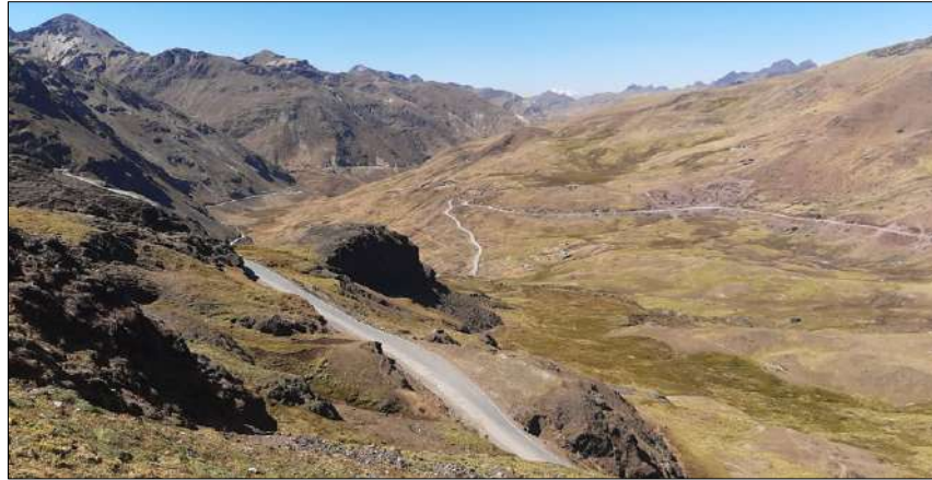
Fotografía 5: Vista donde se aprecia el pie de montaña en el Km 04+500.
