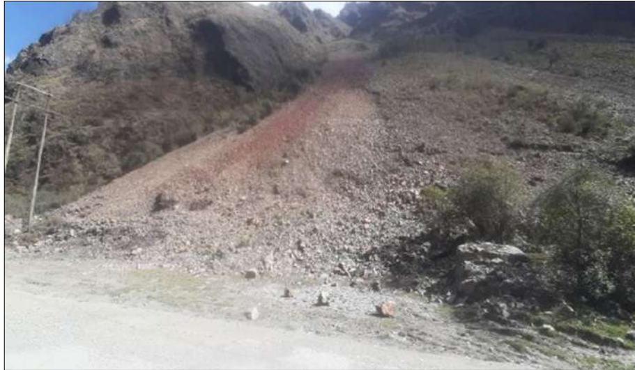
Fotografía 27: Desprendimiento de clastos de rocas (detritos) dispuestos sobre el talud superior de la vía
