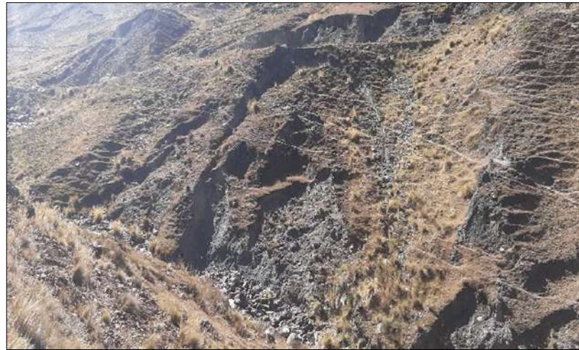
Fotografía 19: Cuerpo de deslizamiento talud inferior Km 00+320 Km 00+345.
