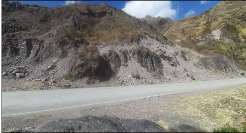
Fotografía 22: Cuerpo de deslizamiento en actividad por sobresaturacion y uso desmedido de material de préstamo cantera.
