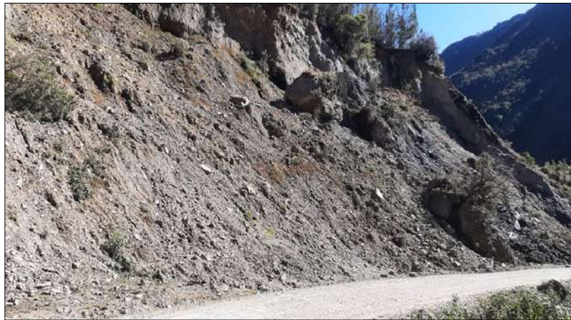
Fotografía 8: Deslizamiento activo compuesto por material de cobertura limoarcillosa con clastos de rocas pizarras, dispuestas sobre afloramiento rocoso - Km 29+260 a Km 29+440.
