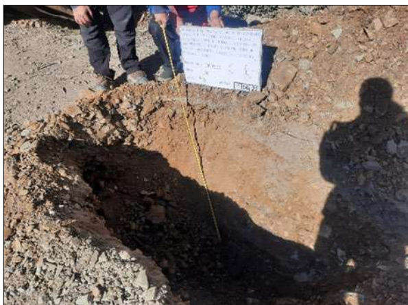
Fotografía 16: Apertura de Calicatas a lo largo de la vía para la evaluación de la Subrasante.
