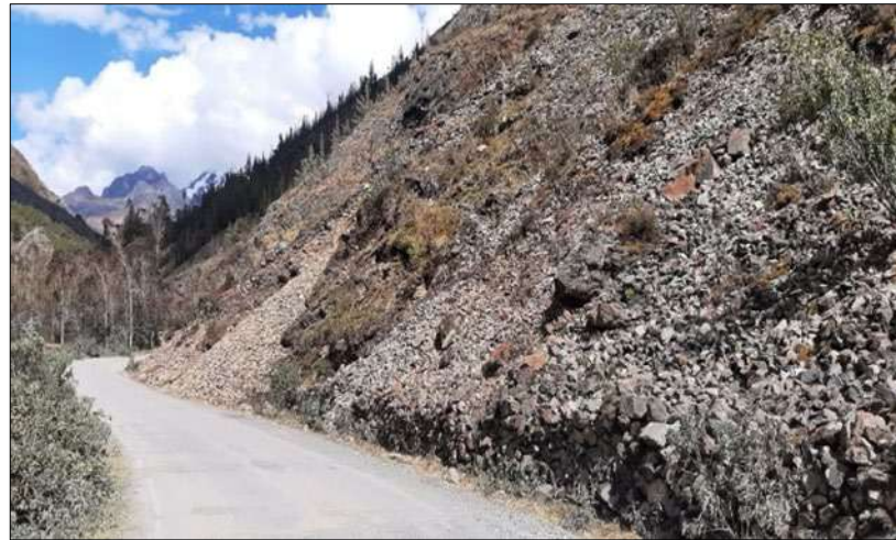
Fotografía 25: Desprendimiento de clastos de rocas (detritos) dispuestos sobre el talud superior de la vía.
