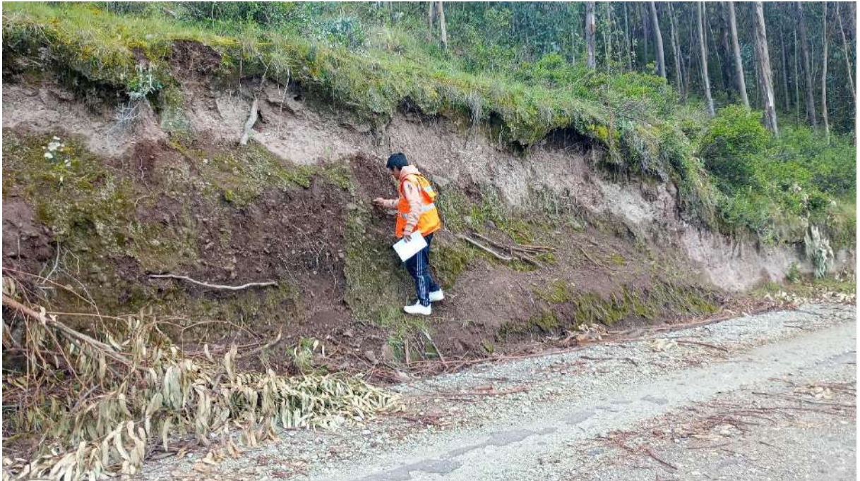
Foto N°5: Rehabilitación de carretera y deforestación. Fuente: Propia
