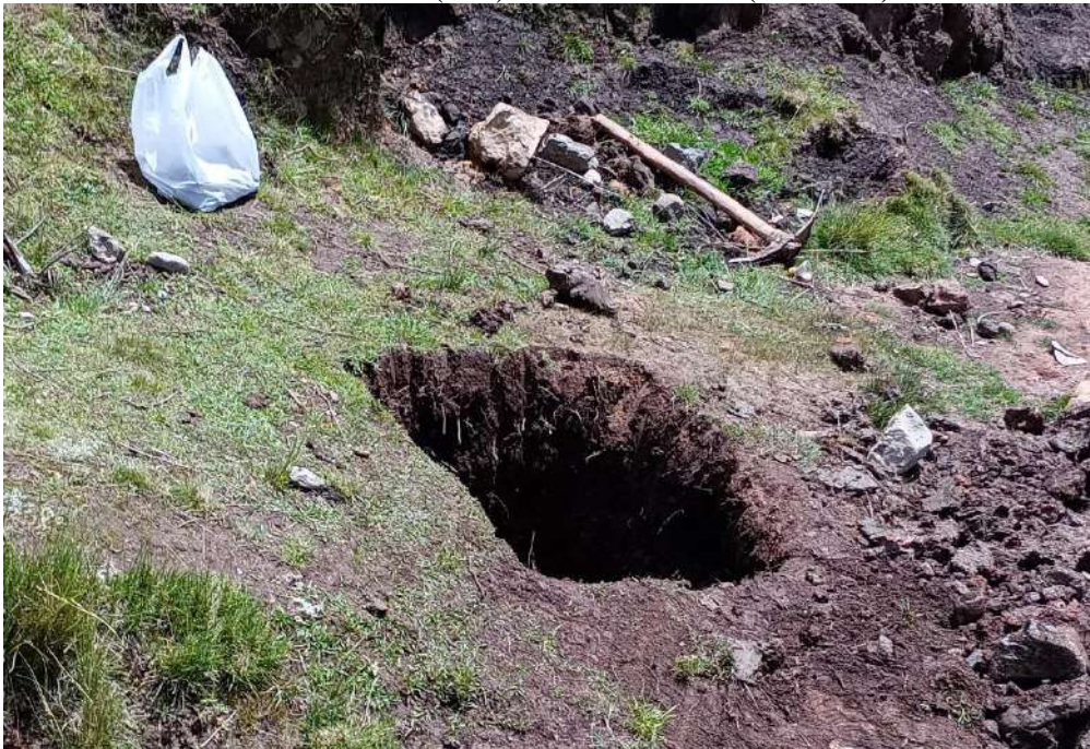
Foto N°14: recogida de muestra de la calicata en la progresiva (05+0000) observándose dos estratos una con arenisca rojiza y la otra arenisca oscura y con un suelo moderadamente duro y poca humedad, Fuente: Propia
