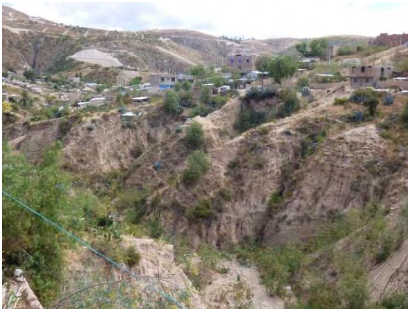
Fotografía 21. Vista de erosión de laderas de tipo cárcava, ubicado en el sector de Mollepata.
