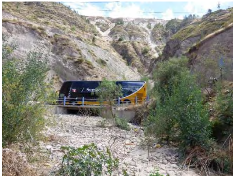
Fotografía 18. Vista de derrumbe antiguo con actividad inactiva latente, donde se observa el depósito adosado al pie de la ladera.
