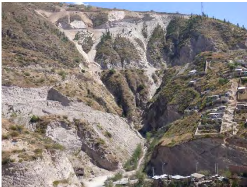
Fotografía 19. Vista de la erosión de laderas de tipo cárcavas, ubicado en la ladera este del cerro Buena Vista.
