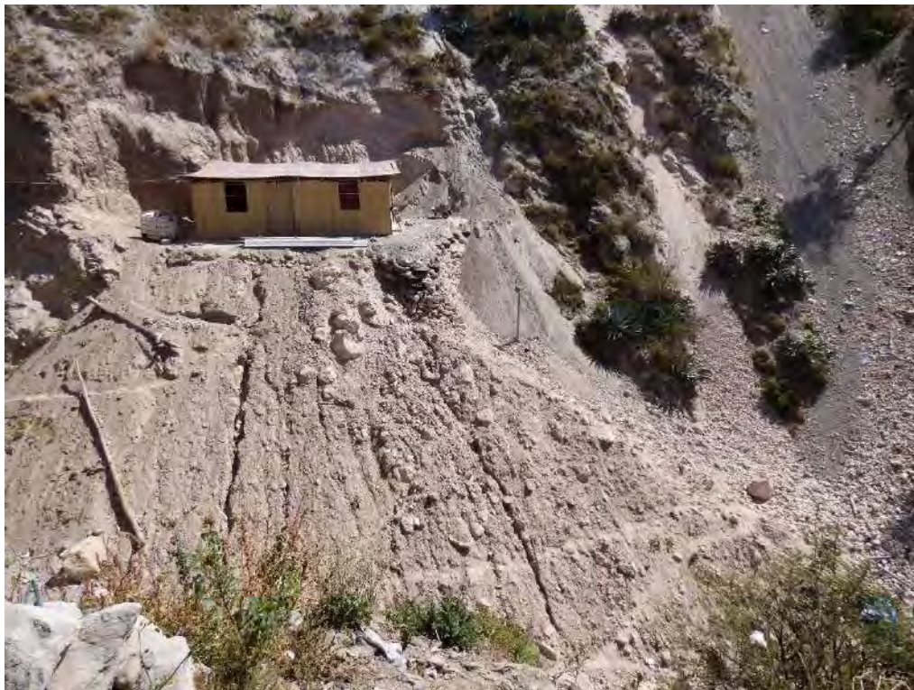
Fotografía 27. Vivienda asentada sobre material de depósito, producto del corte de talud, se encuentra asentada en la ladera izquierda del cauce de la quebrada, zona considerado con nivel de peligrosidad alta.
