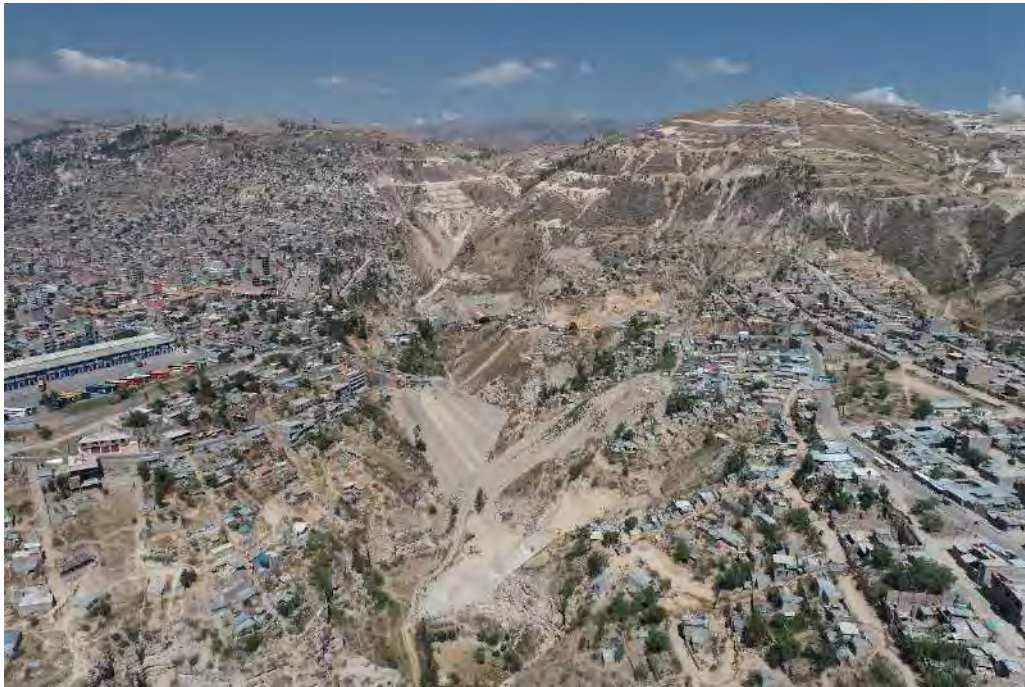
Fotografía 24. Vista del cauce principal de la quebrada Picota, observándose depósitos de desmonte en las laderas de ambas márgenes del cauce, zona con nivel de peligrosidad Muy Alto para a ocurrencia de derrumbes.
