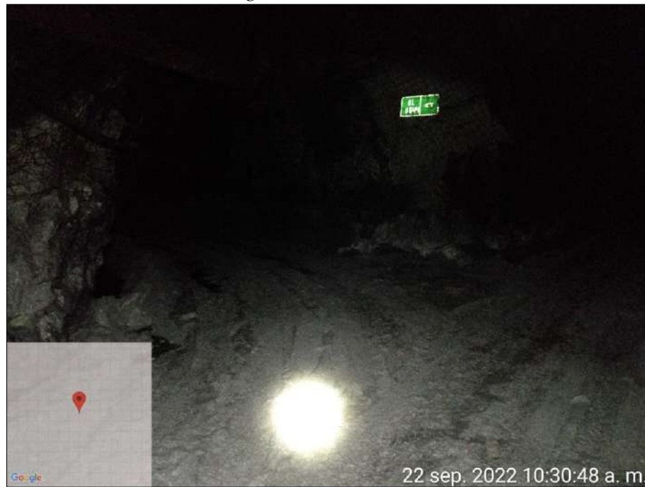
Fotografía 12 Vista al Sur del ingreso a la GL-0644S, nivel 3
