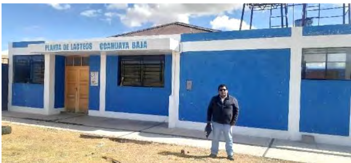
Foto N° 14: Planta de lácteos Ccahuaya Baja, Pichigua - Espinar
