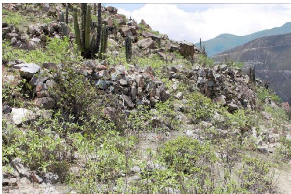
Detalle del muro de contención 83 (Mc-83)
