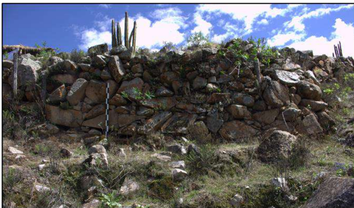
Vista frontal del muro de contención Mc-108
