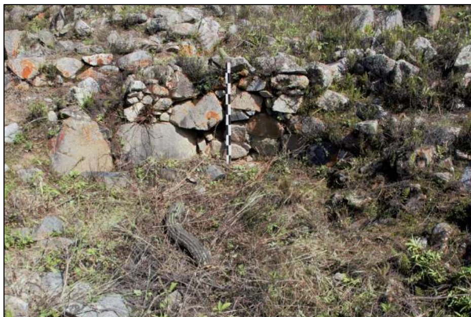
Detalle del muro de Contención 48 (Mc-48)
