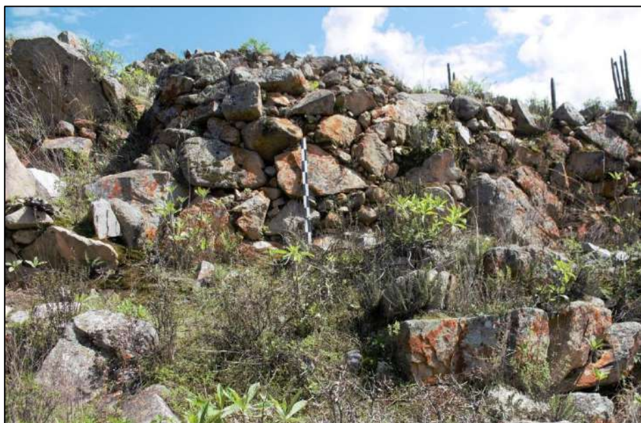
Detalle de muro de contención 119 (Mc-119)
