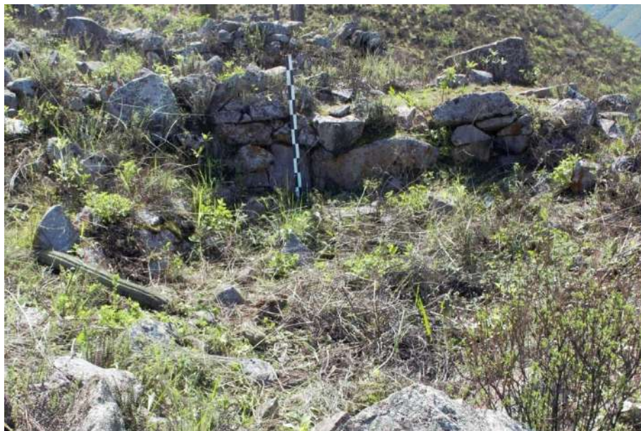
Fragmento del muro de contención 47 (Mc-47)
