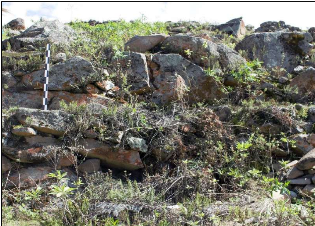
Detalle del muro de Contención 53 (Mc-53)
