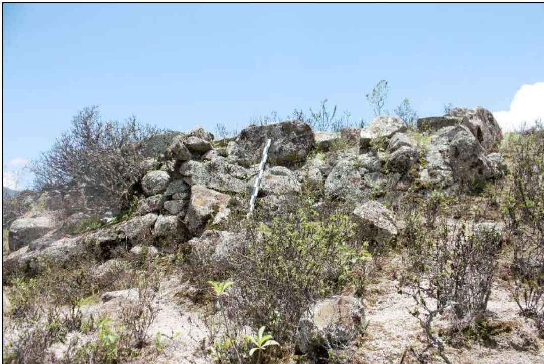
Detalle del muro de contención 06
