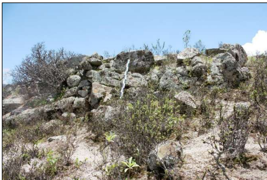
Detalle del muro de contención 90 (Mc-90)
