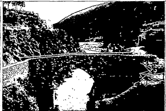
Puente colonial de Checacupe
