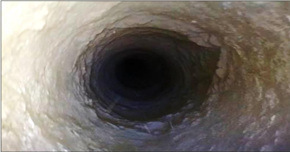
Figura 9. Imagen de la exploración con cámara de pozos
