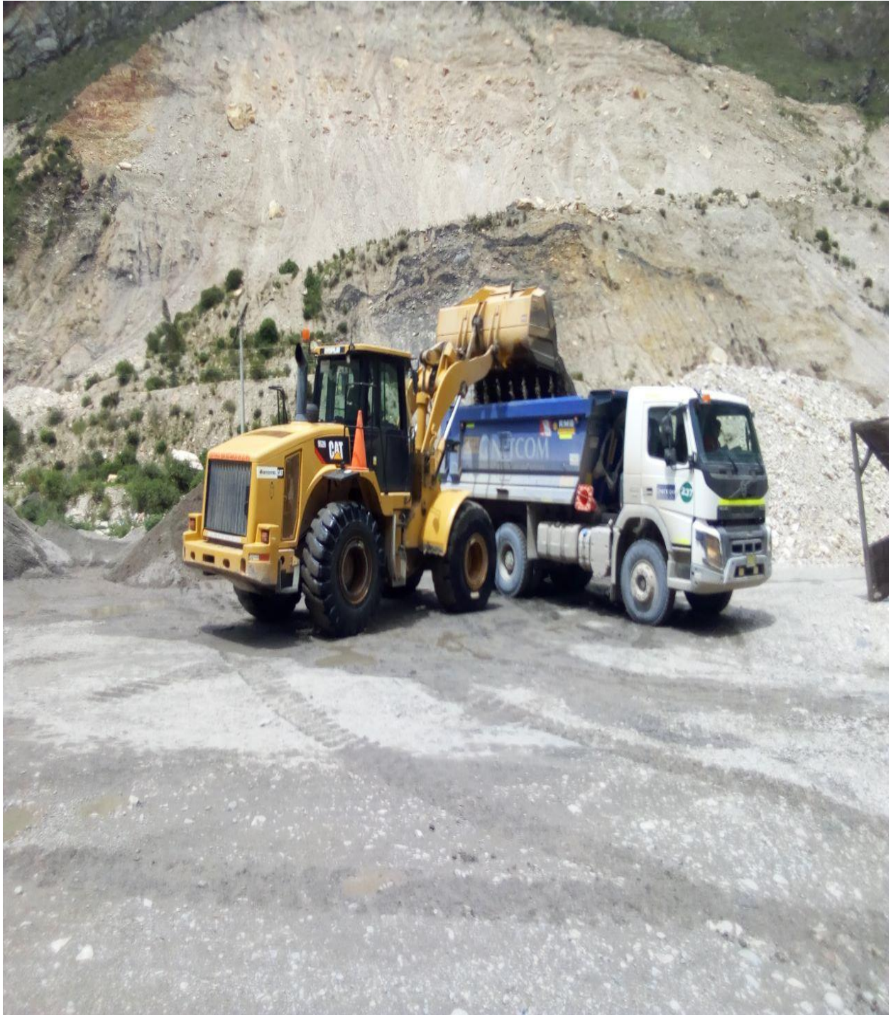
ANEXO 11. Carguío de arena a tolva de volquete, con cargador frontal
