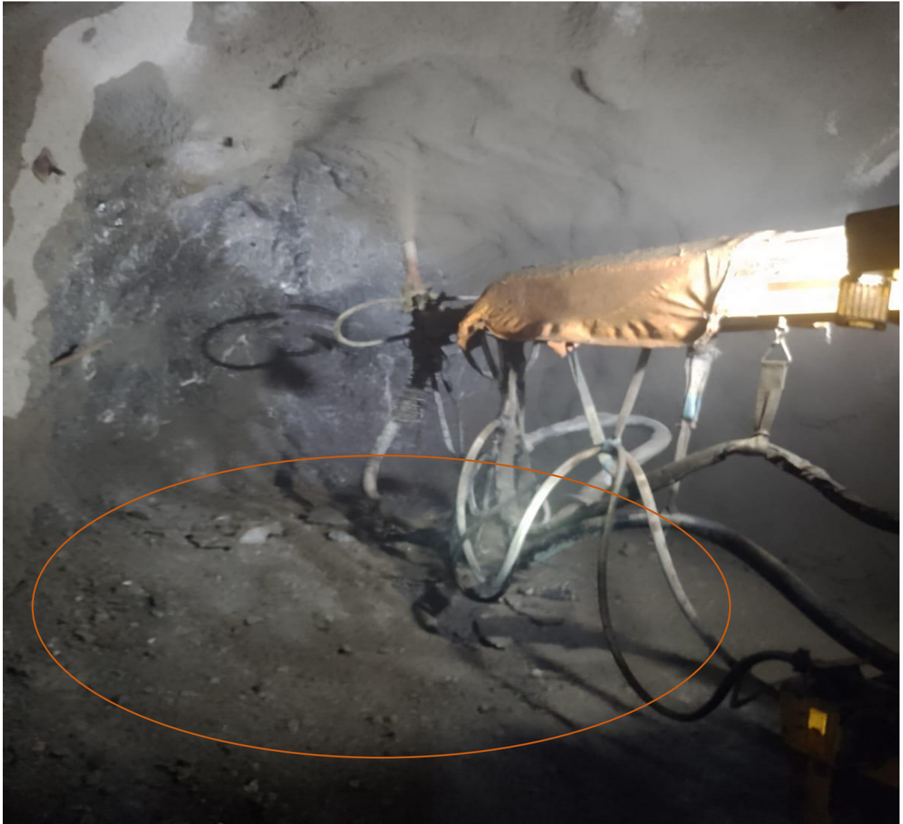
Figura 30: Recolección de muestra del rebote de shotcrete.
