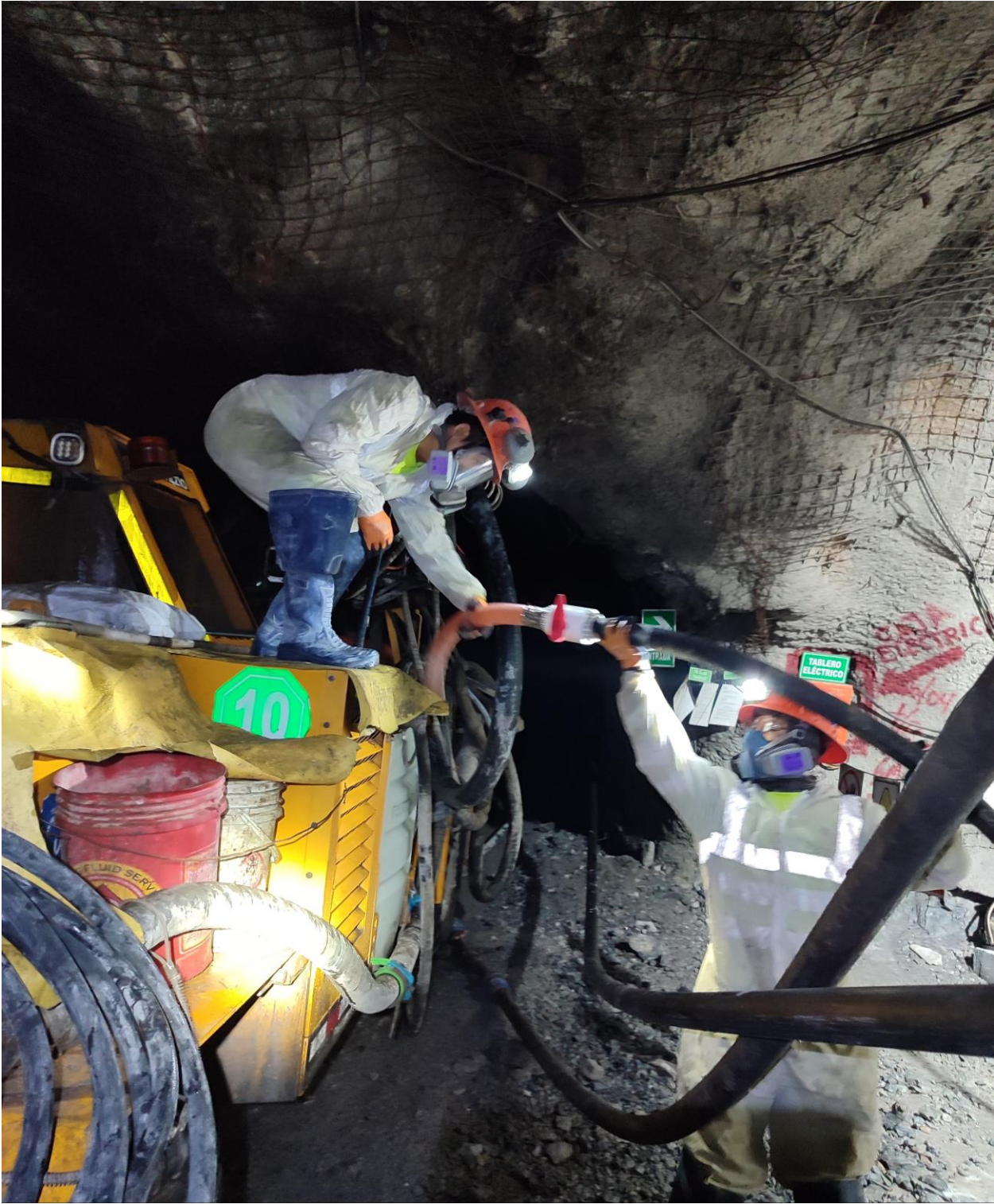
ANEXO 9. Trasegado de aditivo gunitoq a equipo robot
