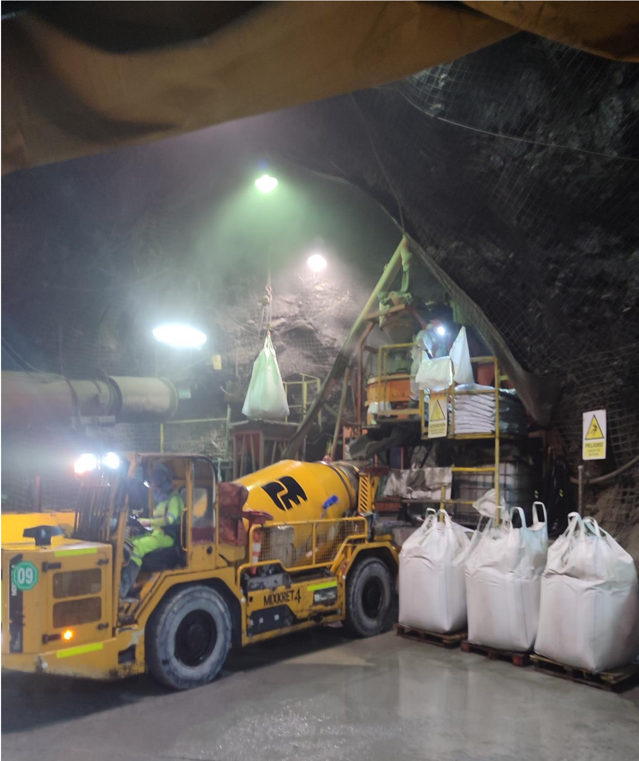
ANEXO 7. Trasegado de concreto premezclado de tina a cuba de mixkret en planta shotcrete
