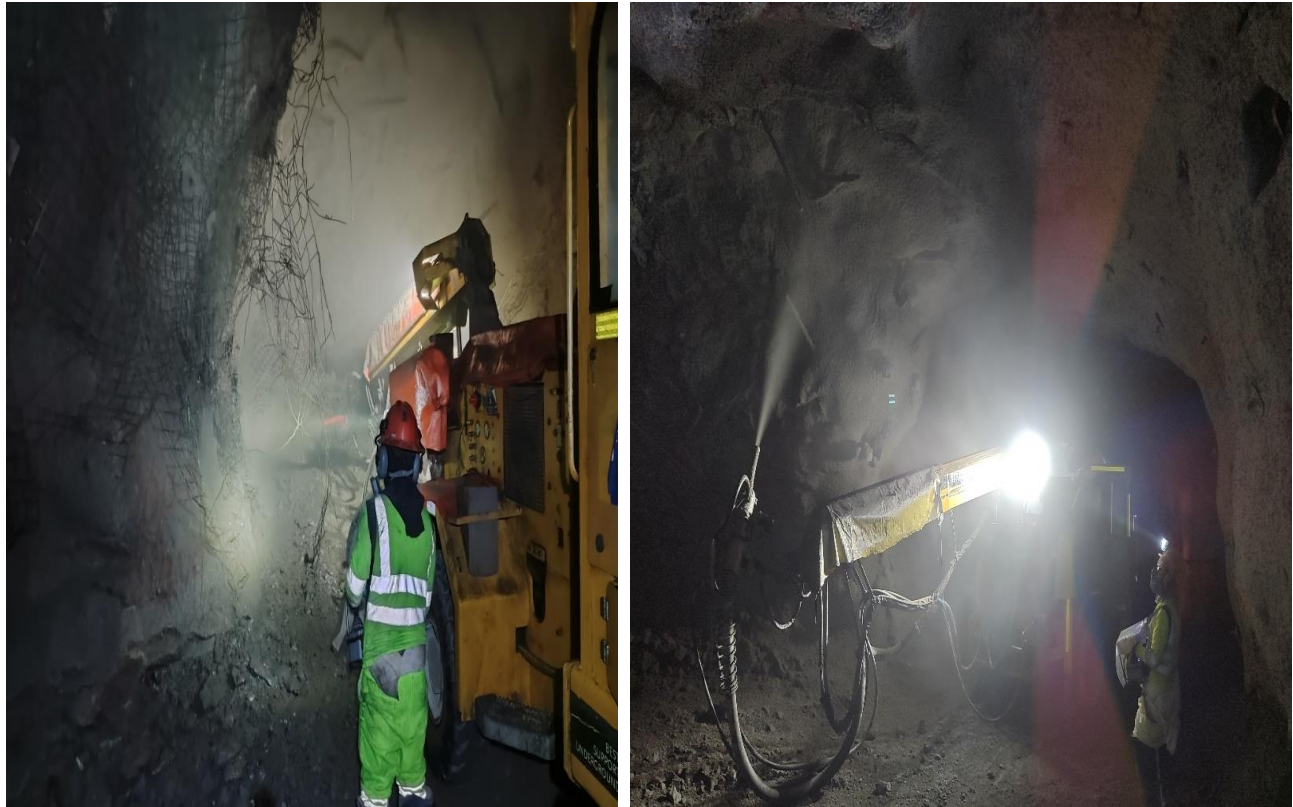
Figura 29: Lanzado de shotcrete en la rampa principal 8600 del nivel 1200 al 1100.
