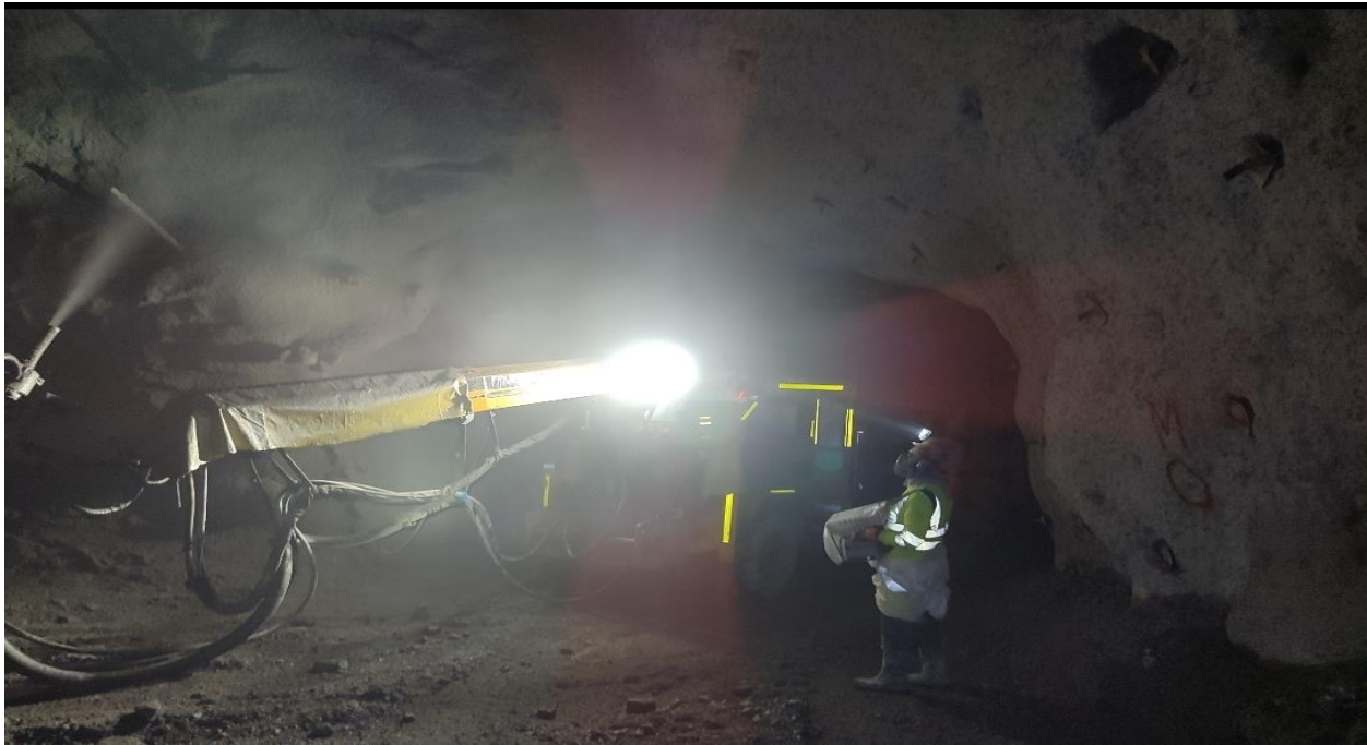
Figura 26: Equipo putzmeister SPM. 4210 (equipo robot) en lanzando.
