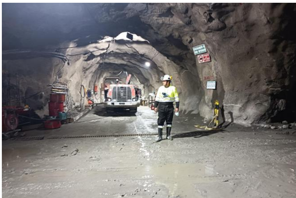
Foto 17: Mejoramiento de la plataforma de la rampa (-) 4577 – progresiva 1+000
