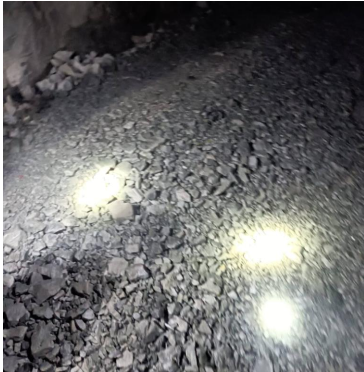
Foto 14: Relleno de vía de acarreo con material
