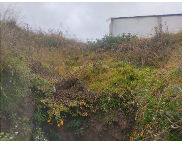
Fotografía 27: Ausencia de cerco de protección
