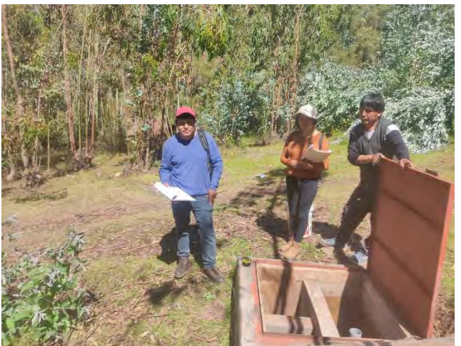
Fotografía 06: Cámara distribuidora de caudales
