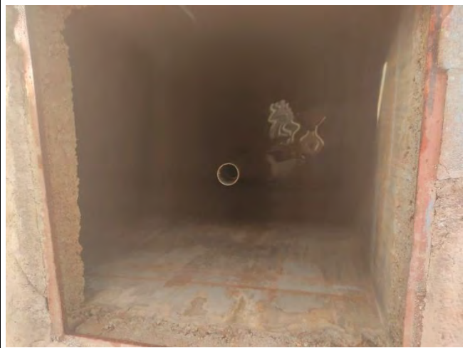
Fotografía 32: Interior de reservorio
