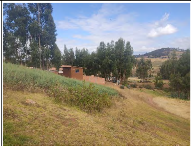
Fotografía 36: Red de distribución
