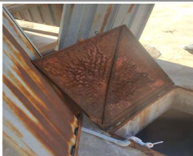
Fotografía 20: Tapa sanitaria reservorio Capulichayoc
