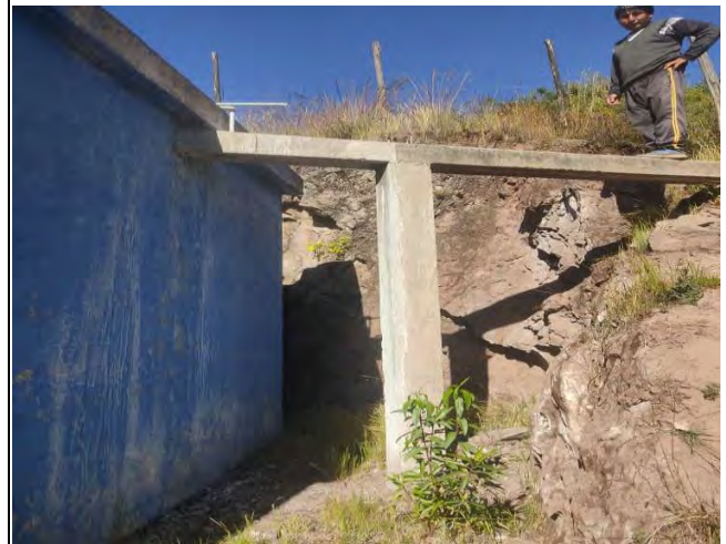
Fotografía 10: Pase aéreo en la línea de conducción
