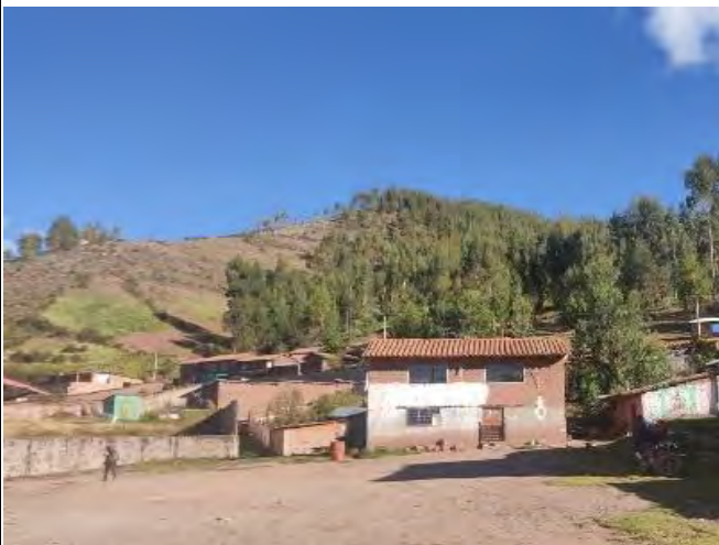
Fotografía 48: Red de distribución
