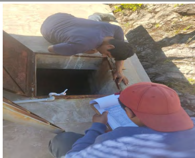
Fotografía 19: Interior de reservorio Capulichayoc
