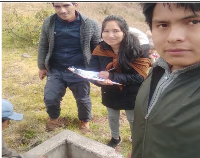
Fotografía 29: Válvula de aire
