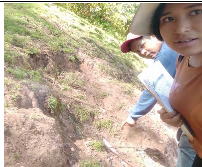
Fotografía 11: Tubería expuesta línea de conducción
