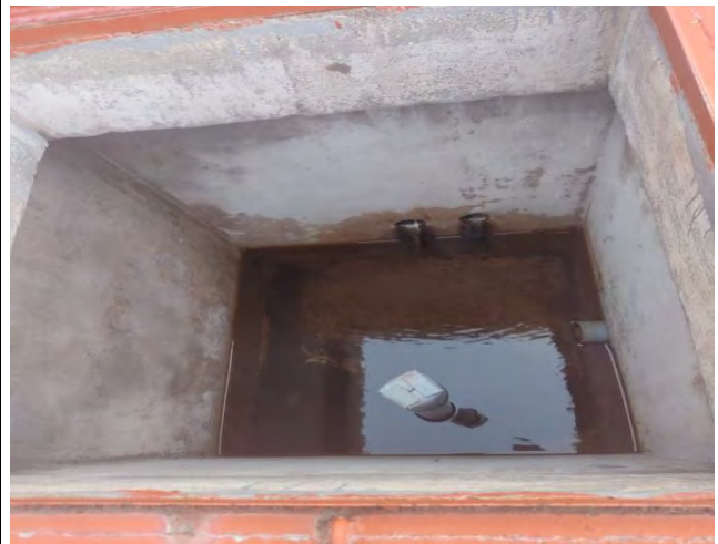
Fotografía 40: Cámara húmeda Choquepata 2
