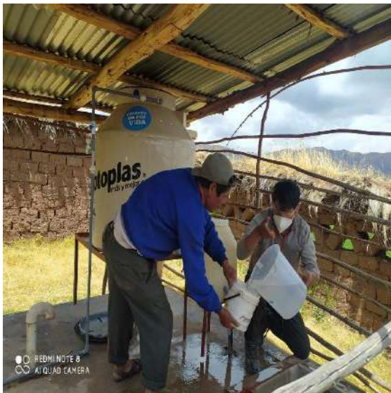
FOTO 21: acompañamiento técnico en actividades de cloración con el gasfitero de la JASS.
