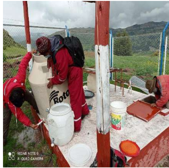
FOTO 24: limpieza y recarga de cloro para la desinfección del agua para consumo
