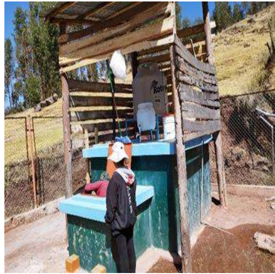
FOTO 6: reservorio 2 del SAP de Rumaray.
