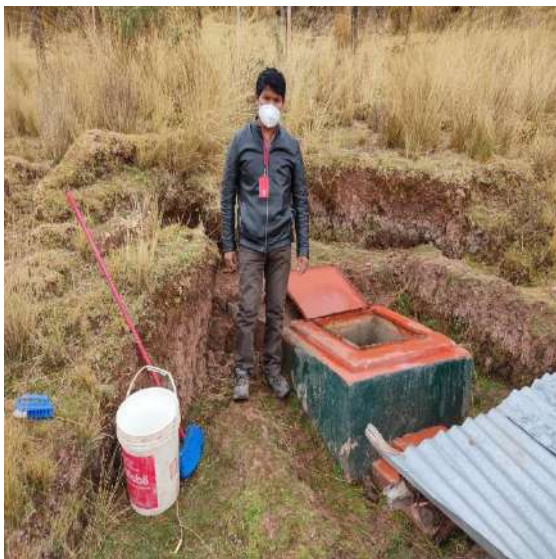
FOTO 3: captación Uñaincapujio del SAP de San Isidro de Carhuis.
