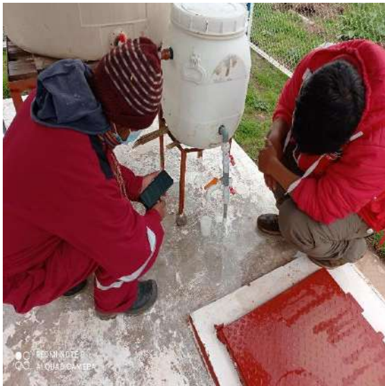
FOTO 25: calibración del goteo en el segundo recipiente del sistema de cloración.
