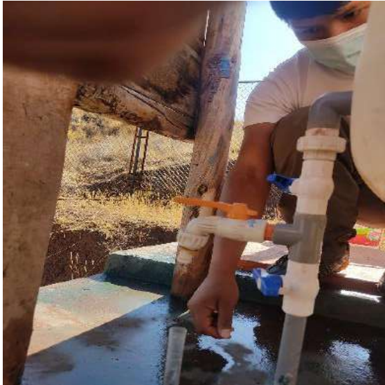
FOTO 19: calibración del goteo en el segundo recipiente del sistema de cloración
