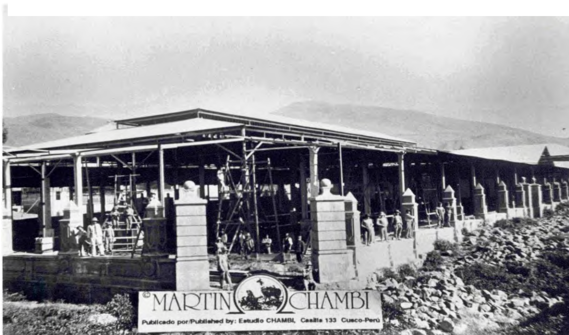
Imagen 27: Construcción del Mercado Frisancho.
