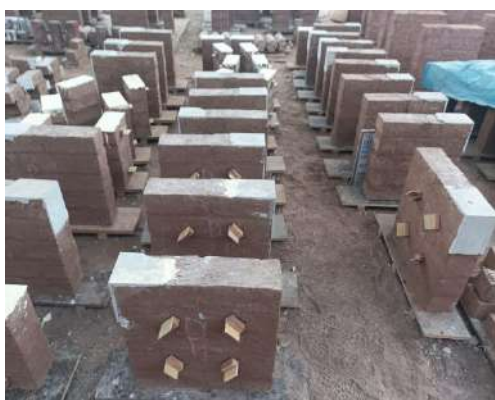
Colocación de topes en Muretes de adobe
