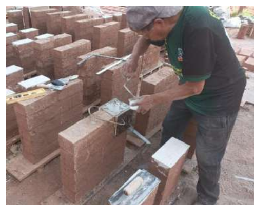
Colocacion de caping en Muretes de adobe
