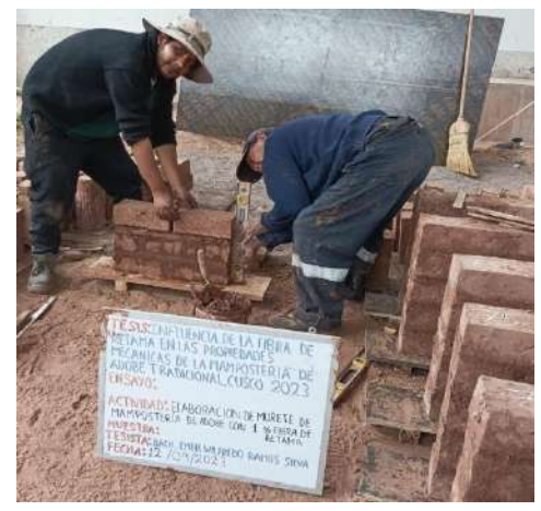
Murete de adobe con 1.0% en peso de fibra de retama
