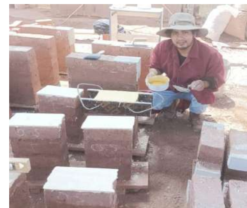
Colocacion de caping en las pilas de adobe
