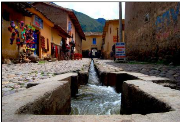
Figura 224: Canal de agua, propio del urbanismo e ingeniería andinos (fotografía)
