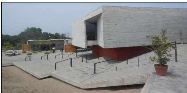
Figura 114: Escaleras del MSP (fotografía). Fuente: Propia, 2019.
